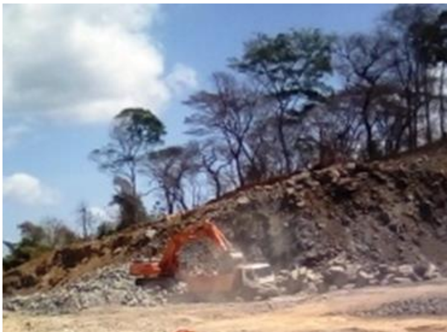
Vista de trabajos de remoción de material pétreo luego de voladura
