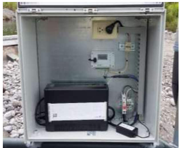
Imagen No.7 y 8. Área de la compuerta rio Chuspa, el sistema para control de caudal utilizado. Permite llevar registro de datos.
