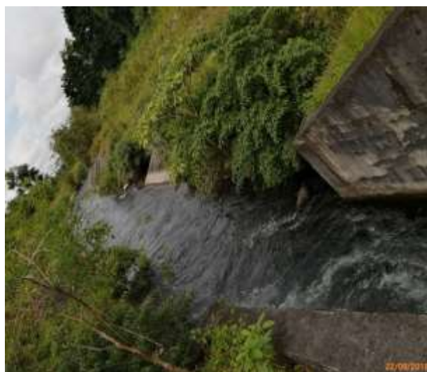
Imagen No.19, 20. Salida del agua de Casa Máquina, es conducida por un canal que dirige y descarga devolviendo el agua a su fuente natural, río Piedra. CHMacano.
