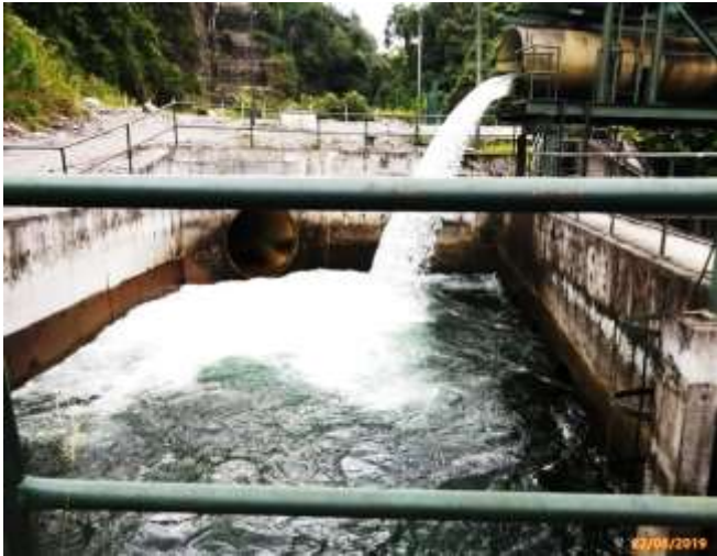
Imagen No.1, 2 del 22/08/2019 Descarga del agua de la bocatoma del río Chuspa hacia su conducción Rio Piedra
