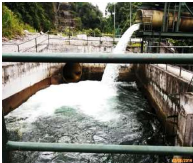
Imagen No. 6 y 7. 22/08/2019. Canal de conducción que sale del desarenador del río Chuspa hacia el trasvase con el río Piedra.
