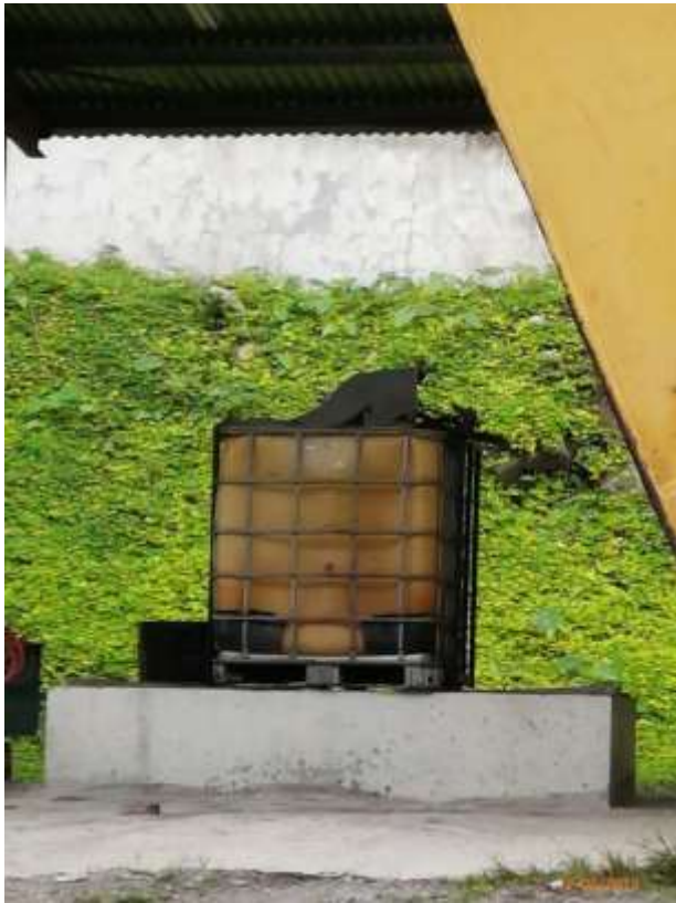
Imagen No.1. Tina de control de residuos derivados del hidrocarburos. Imagen 2. Pad absorbente para usarse al presentarse contingencia por derrame de hidrocarburos
