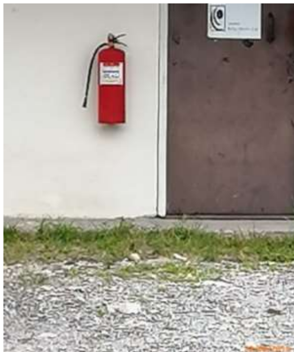
Imagen No. 1,2. Instalación de extintores en dos puntos en área de casa máquinas., sellados
