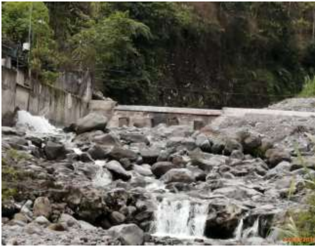
Imagen No.1 y 2 del 22/08/2019 Se observa que el paso del agua rebasa la cresta. Se conserva y registra el caudal ecológico. Presa río Chuspa
