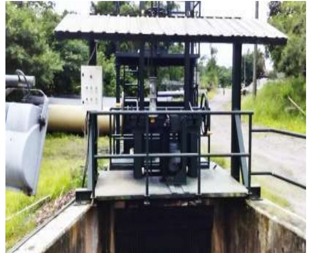
Imagen No. 5, 6. Área de la compuerta rio Piedra, el sistema para control de caudal utilizado. Permite llevar registro de datos.
