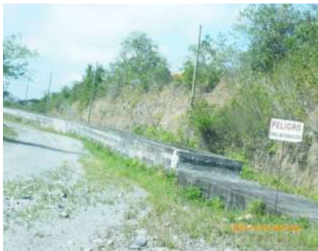
Imagen No.3, 4 y 5. 22/08/2019 Se observan los canales que conducen el agua del Río Piedra y por el canal de conducción hacia casa máquinas
