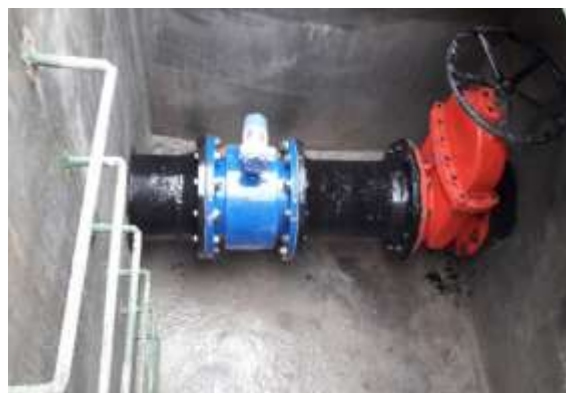
Imagen No. 4 y 5. Caudalímetro para medir CAUDAL ECOLOGICO. Río Piedra.
