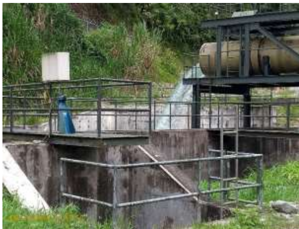
Imagen No1, 2. Estación limnigráfica. Sistema de medición y registro de caudales
