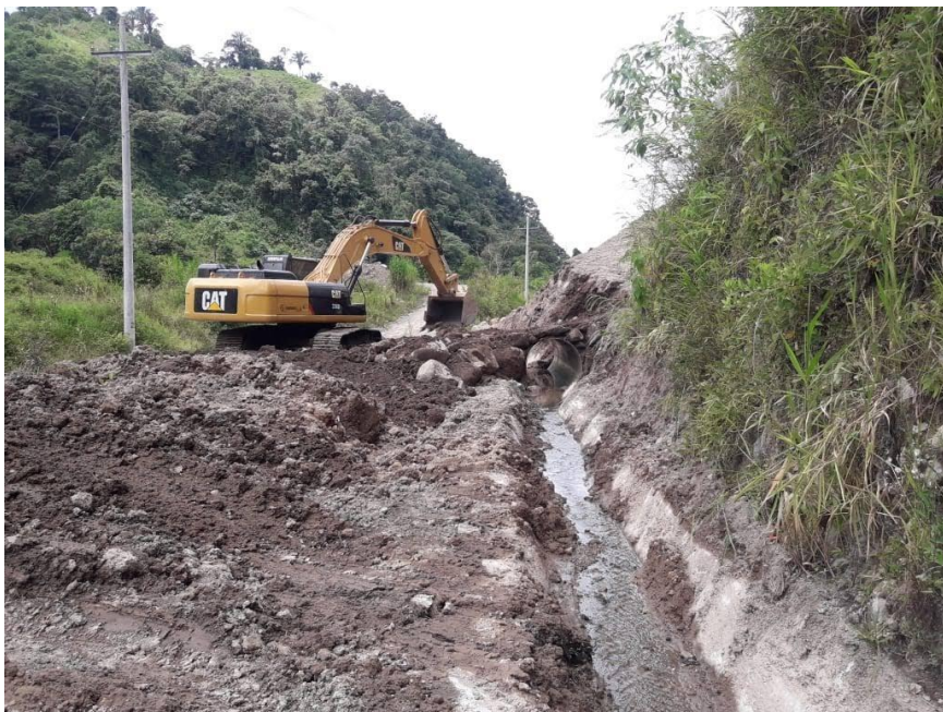
Figure 3: mantenimiento de cunetas
