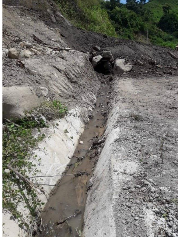
Ilustración 3: Mantenimiento de las cunetas
