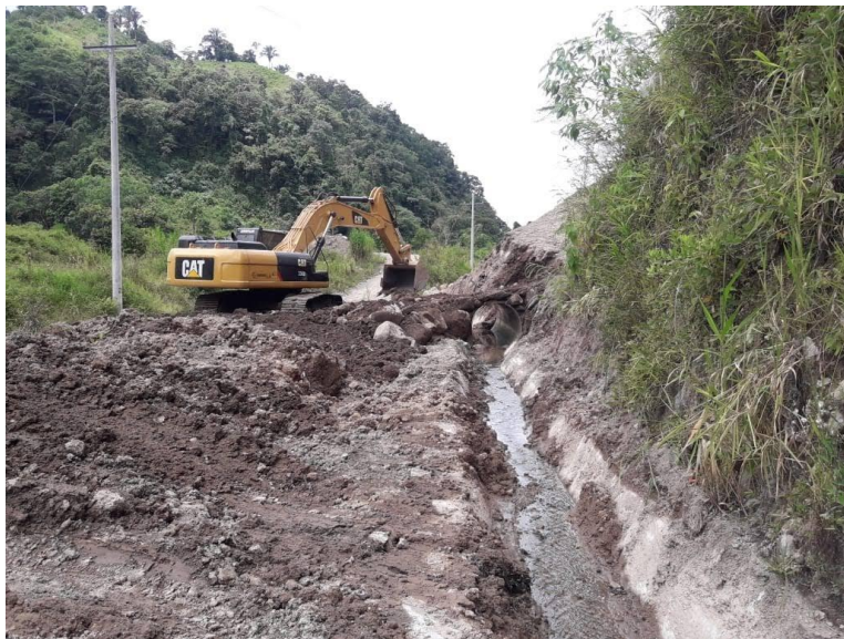
Ilustración 4: Mantenimiento de las cunetas y accesos
