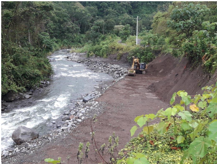
Figure 6: enrocado para control de erosión
