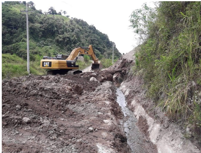
Ilustración 1: Mantenimientos de cunetas
