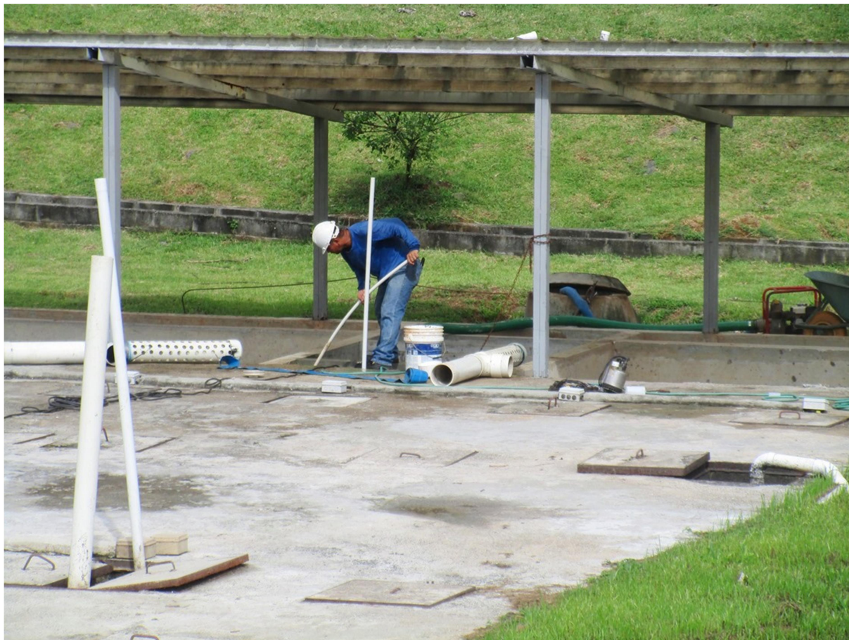
Fotografía 30 Mantenimiento a las eras de secado de la planta de tratamiento
