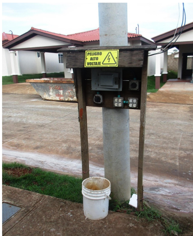
Fotografía 20 Temporal eléctrico techado, con tomacorrientes adecuados para los distintos voltajes, techados
