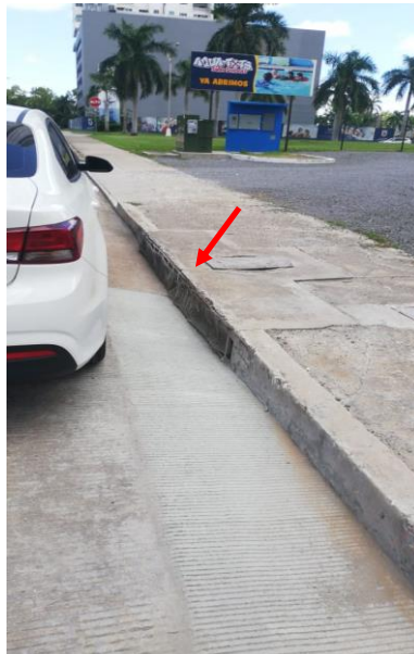
Fotografía No. 15. Protección de tragantes pluviales. Se evidencia la colocación de malla para prevenir que sedimentos ingresen al sistema pluvial.
