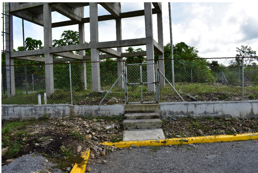
Foto 15 Construcción de cerca perimetral de protección Proyecto Urbanización Los Altos de Gariché - Etapa III
