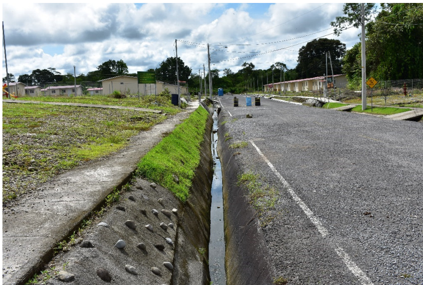
Foto 9 Acondicionamiento de la red de drenajes Proyecto Urbanización Los Altos de Gariché - Etapa III
