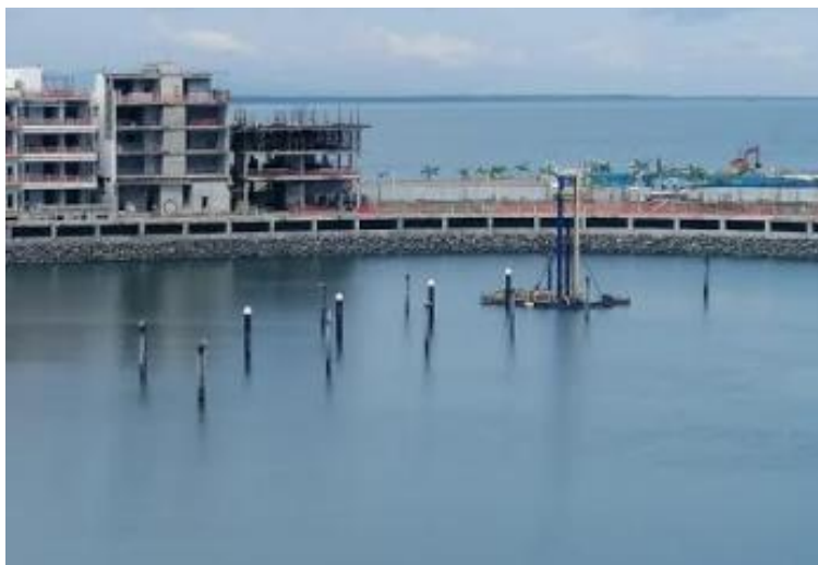
Foto 3: Se observa Pilotera dentro del área, para los trabajos de instalación de los pilotes, que serán el soporte de las estructuras flotantes.
