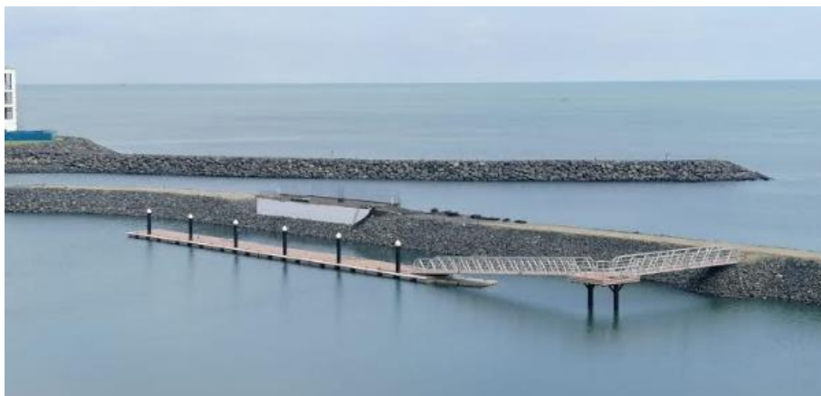
Foto 1: Se observa escollera # 1 terminada con la rampa de acceso para slip flotante.
