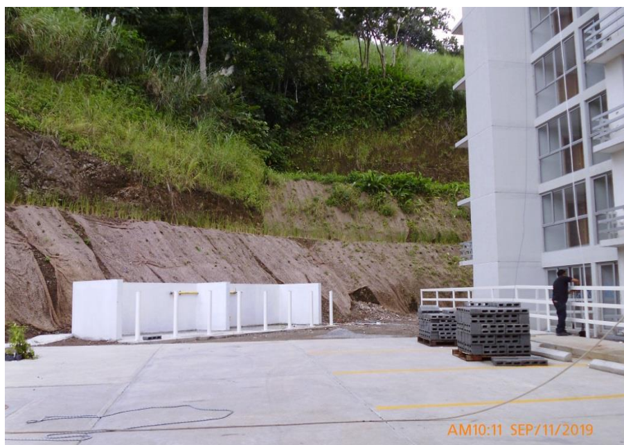
Fotografía # 3. Revestimiento de taludes con malla de coco y grama. Paisajismo
