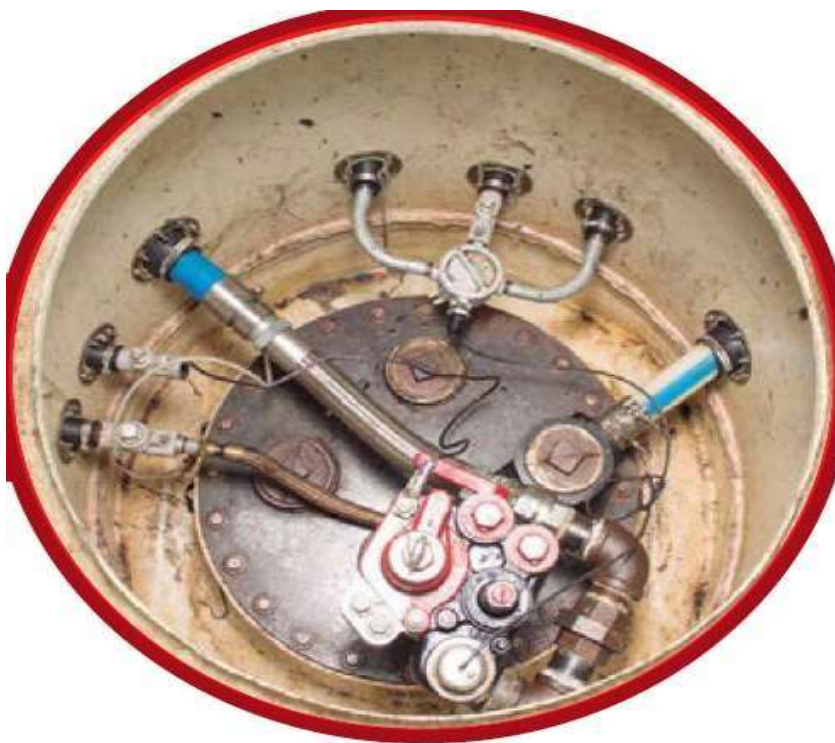
Figura 7. Bomba sumergible, 1.5 HP marca Red Jacket, FE Petro.
