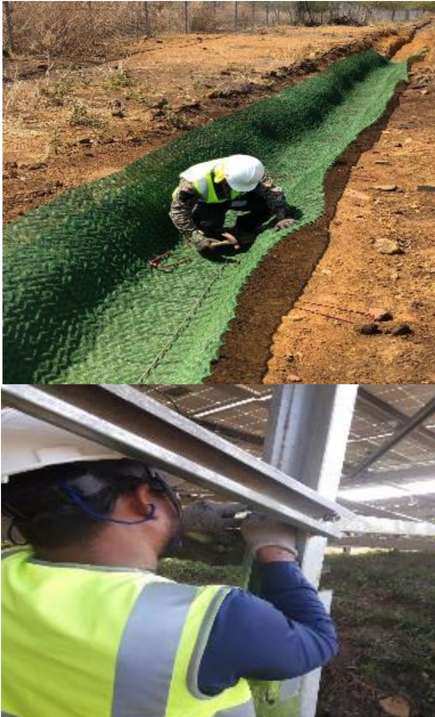
Fotografía 1 - 2: Personal portando el EPP (casco, uso de barbiquejo, botas y camisas reflectivas). Todo el personal que se encuentra dentro del área del proyecto deberá contar con su equipo de seguridad de acuerdo con la actividad que realice.
