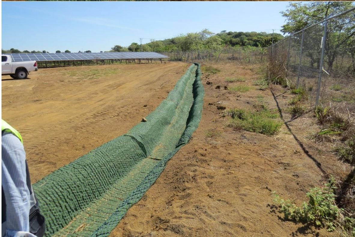
Fotografía 15-16: Colocación de Malla de Geotextil en el drenaje para desalojar el exceso de agua en el proyecto.
