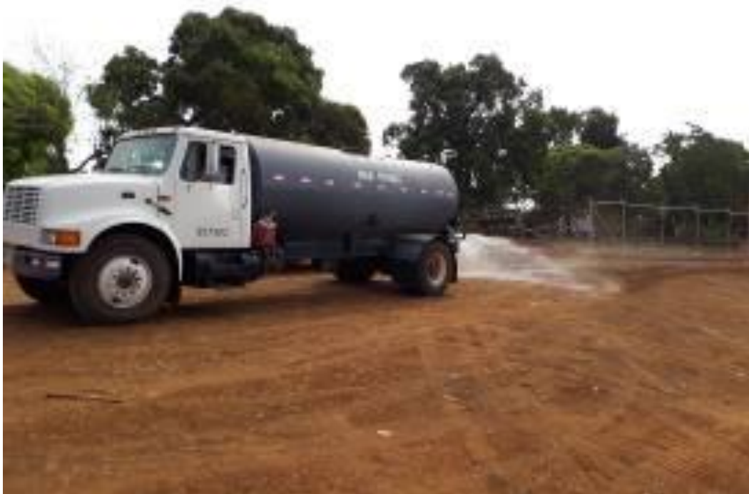
Fotografía 13-14: Camión cisterna realizando el roció en el área del proyecto para minimizar el volumen de polvo que se genere por la acción del viento.
