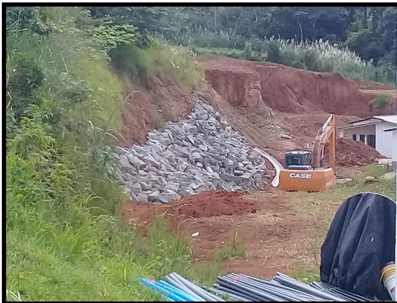
Foto N°14. Utilización de materiales y banquetas para la estabilización de los taludes.
