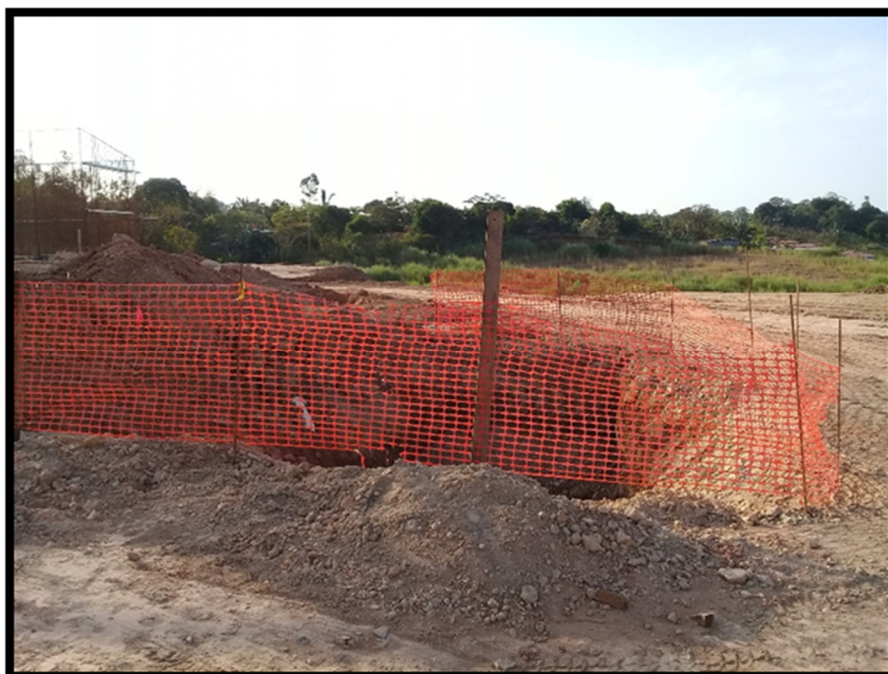
Foto N°2. Señalización con mallas naranjas las áreas abiertas como las excavaciones.
