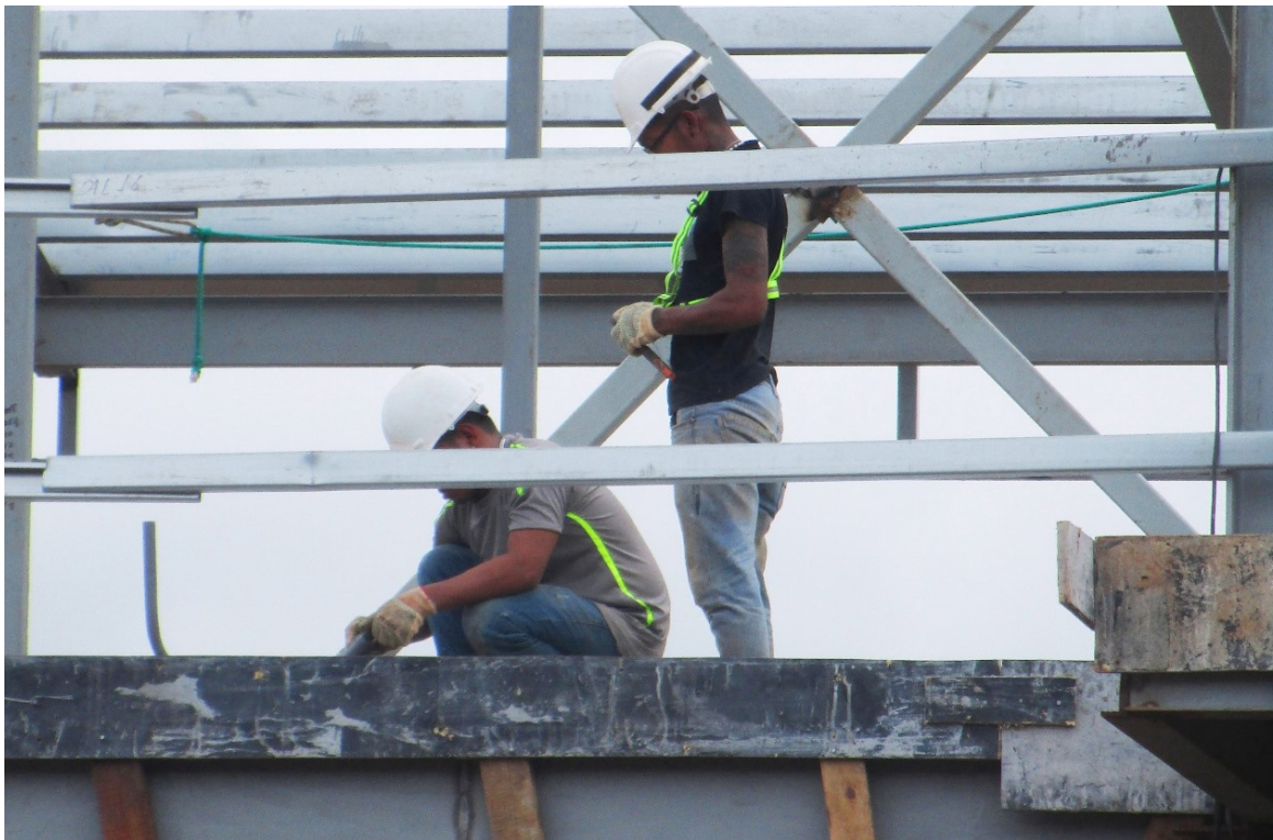
Fotografía 50 Barandales metálicos protegen de caídas los pisos superiores de la estructura
