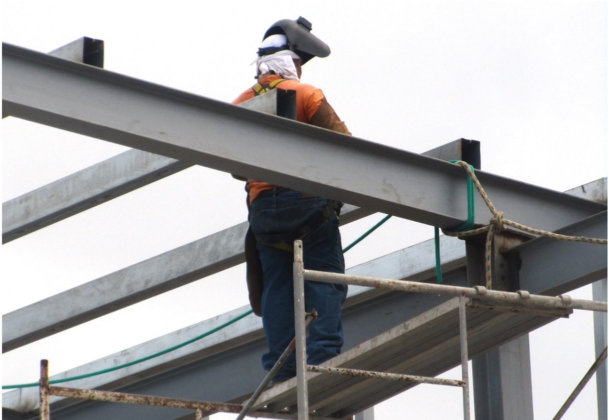
Fotografía 44 Trabajadores con su EPP completo (incluyendo soldador con arnés y línea de vida)
