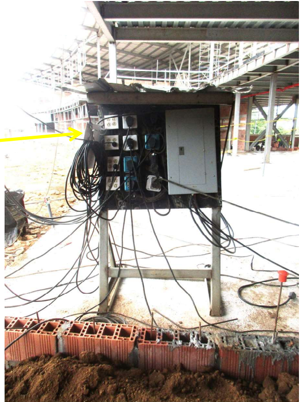
Fotografía 49 Temporal eléctrico con tomacorrientes de 120V/ 220 V (no hay cables pelados conectados), con letrero de precaución eléctrica por presencia de “Alto Voltaje”
