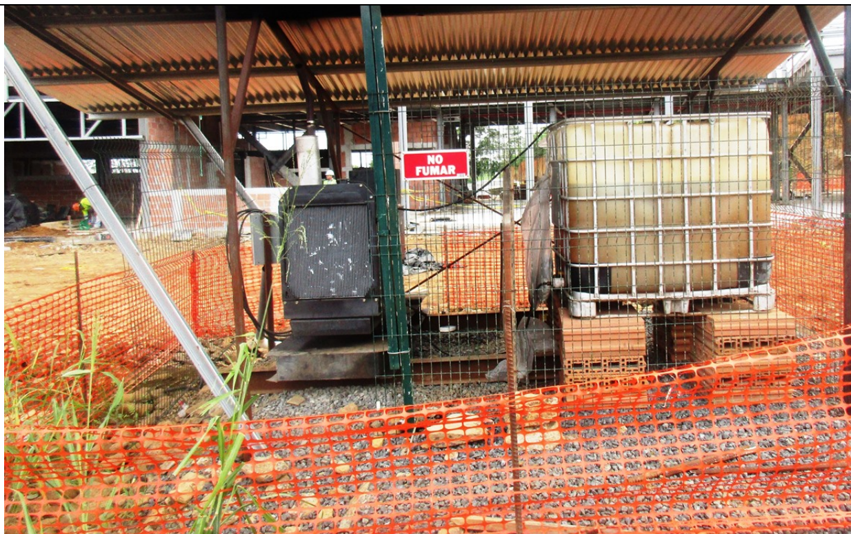
Fotografía 14 Generador eléctrico sin material absorbente para casos de derrames o fugas de hidrocarburos
