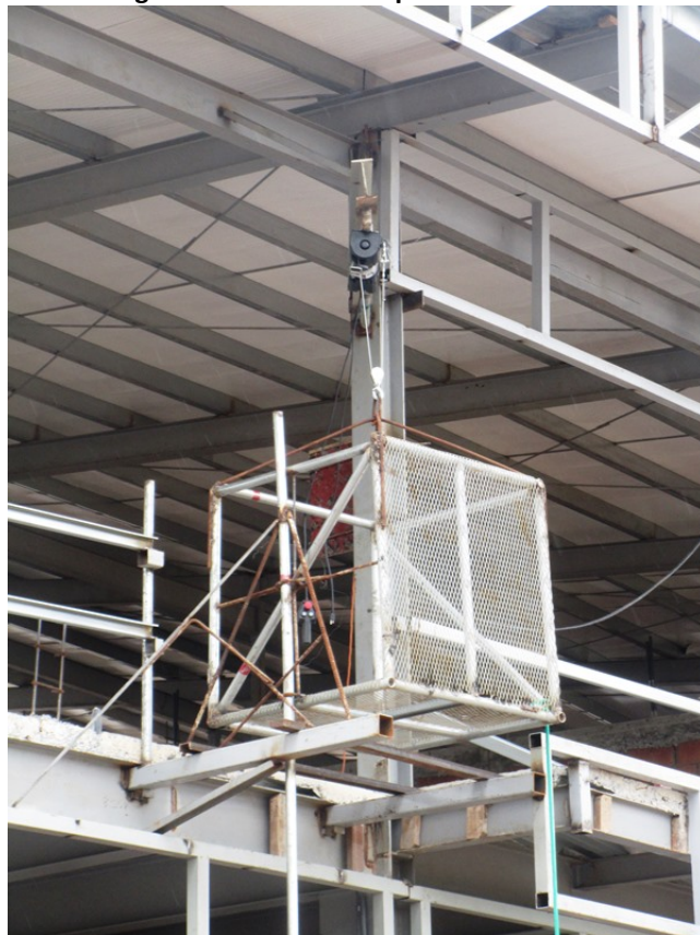
Fotografía 42 Polipasto eléctrico con su canasta para izado de materiales
