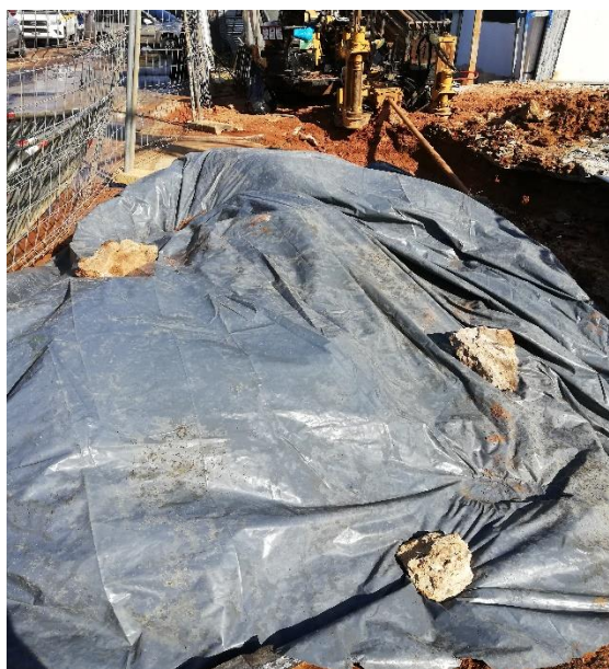
Foto n° 3. Material excavado cubierto con lonas plásticas para evitar aporte de sedimentos.
