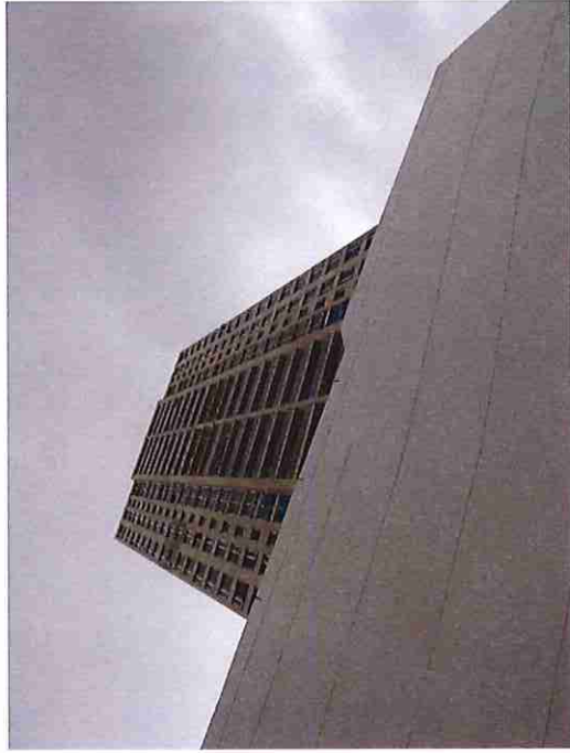
Vista panorámica de la obra:
