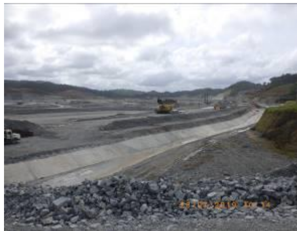
Imagen 10-16. Canal de desviación de aguas en el perímetro del Tajo Botija (977049 N/ 537689 E)
