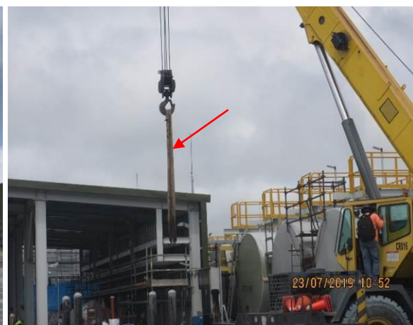
Imágenes 182 y 183. Correa de la eslinga de grúa sin inspección, en el Área MSA (978449 N/ 537164 E)
