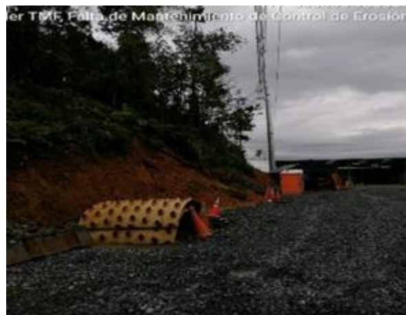
Imagen 383. Ausencia de control de erosión en el Taller TMF (983054 N/ 538806 E)
