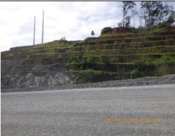
Imágenes 55 y 56. Revegetación (977736 N/ 537233 E) y canales para el manejo de escorrentía (977972 N/ 537244 E) en taludes de Sitio Mina
