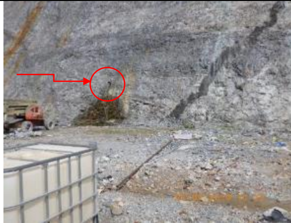
Imagen 57. Drenes horizontales en talud ubicado en el Tajo Botija (977615 N/ 537815 E)
