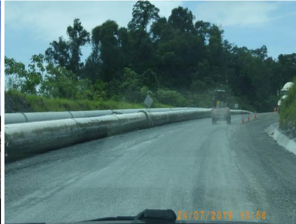
Imágenes 76 y 77. Tuberías de agua de proceso de un diámetro mayor, que van desde la Planta de Procesos hasta la IMR, en el Camino de tuberías o Pipeline road (980721 N/ 539491 E)
