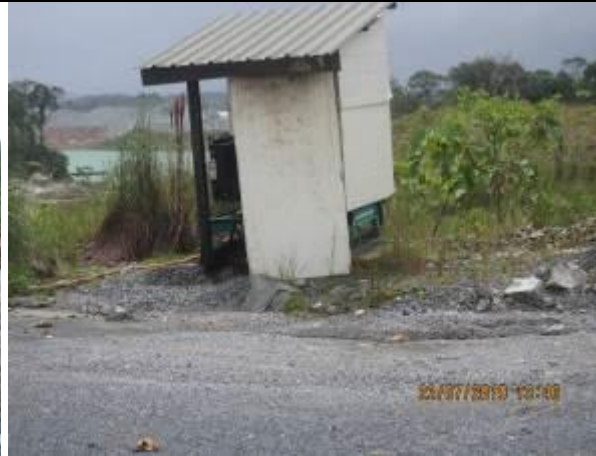
Imágenes 258 y 259. Generadores eléctricos con barrera acústica en el Área 64 (978311 N/ 538900 E)
