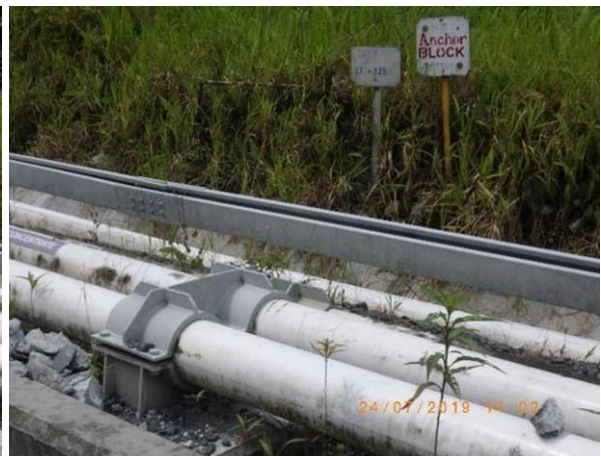
Imágenes 7 y 8. Colocación de estructuras para asegurar el espaciado entre las bridas de los ductos (987162 N/ 535136 E)
