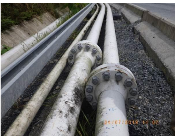
Imágenes 9 y 10. Bridas en contacto con las tuberías del Mineroducto (985470 N/ 537021 E)
