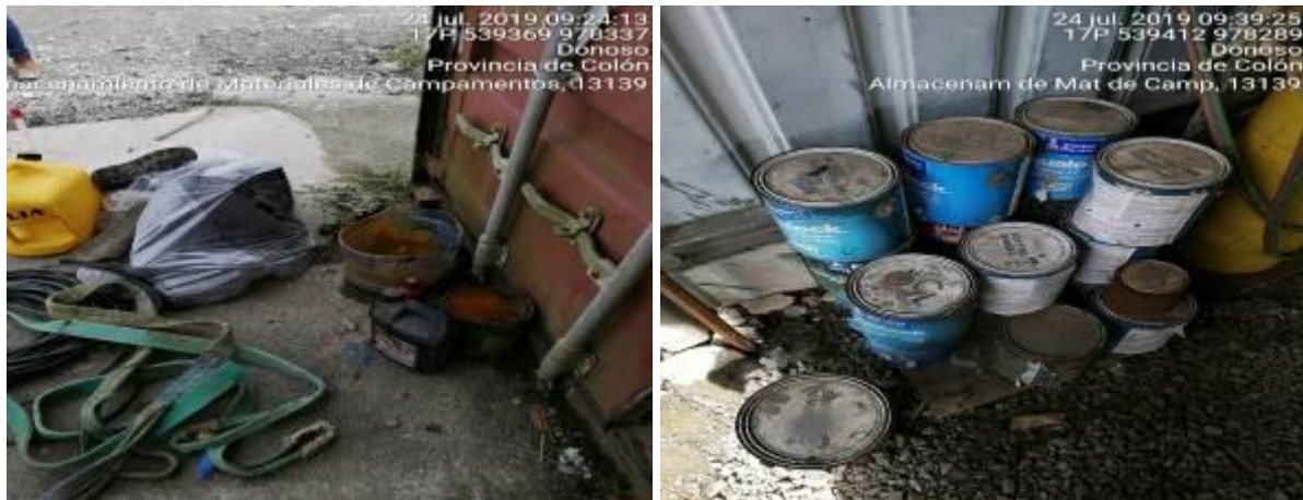
Imágenes 334 y 335. Recipiente de aceite (978337 N/ 539369 E) y recipientes de lubricantes (978289 N/ 539412 E) en el Almacén de materiales de campamentos sin tina de contención
