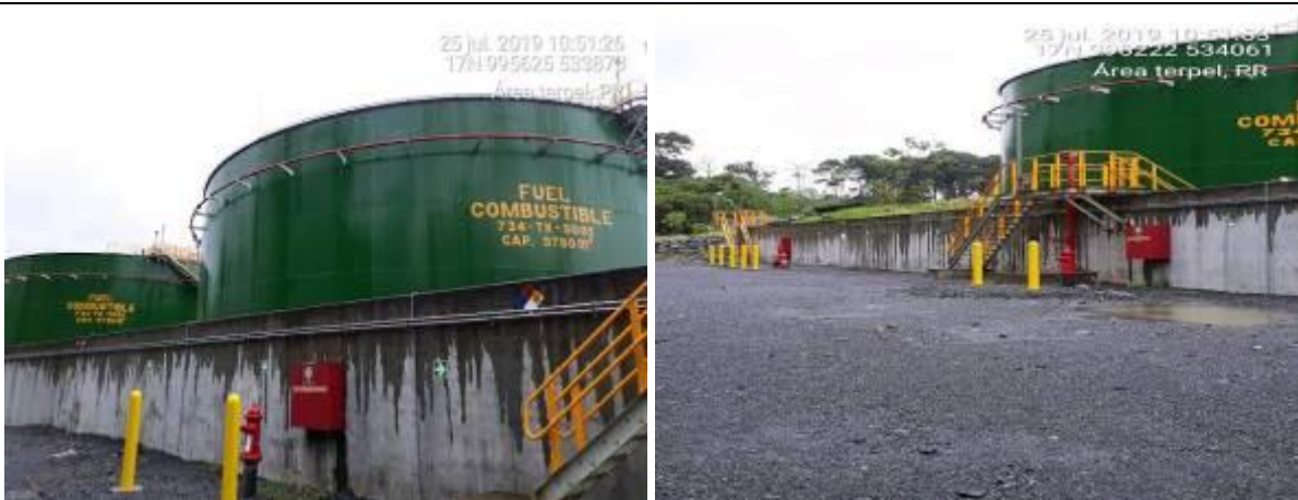
Imágenes 349 y 350. Vista de los tanques de combustible y su tina de contención en el área de Punta Rincón (996222 N/ 534061 E)
