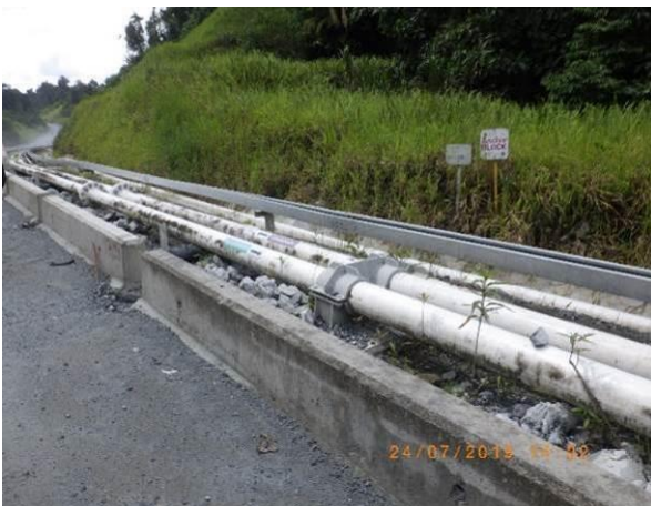
Imágenes 7 y 8. Colocación de estructuras para asegurar el espaciado entre las bridas de los ductos (987162 N/ 535136 E)
