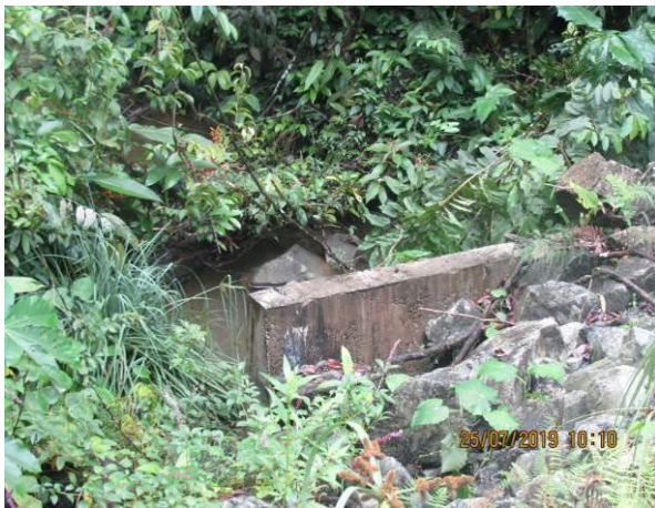
Imágenes 66 y 67. Alcantarilla a ras de suelo que permite el paso de peces aguas arriba y abajo en el Camino Morpho (994377 N/ 533705 E)
