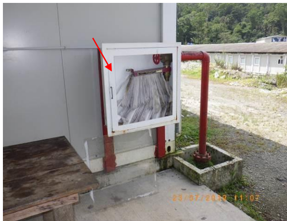
Imágenes 178 y 179. Gabinetes de mangueras contra incendios dañados en el Campamento Cobre (979118 N/ 540033 E)
