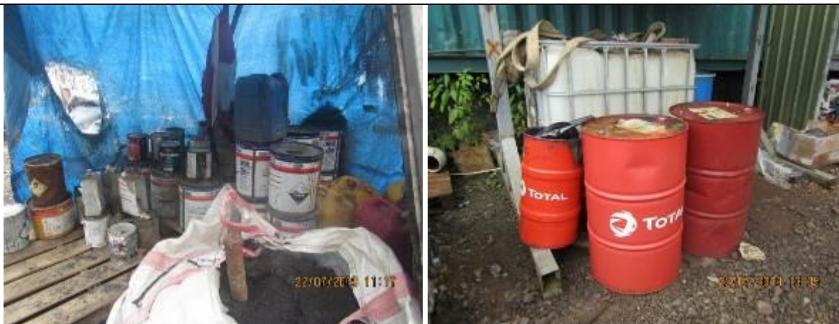
Imágenes 328 y 329. Ausencia de contención secundaria en el Área 22 frente a CONAPRED (978414 N/ 538426 E) y Área 22, frente al Taller de sandblasting (978363 N/ 538133 E)
