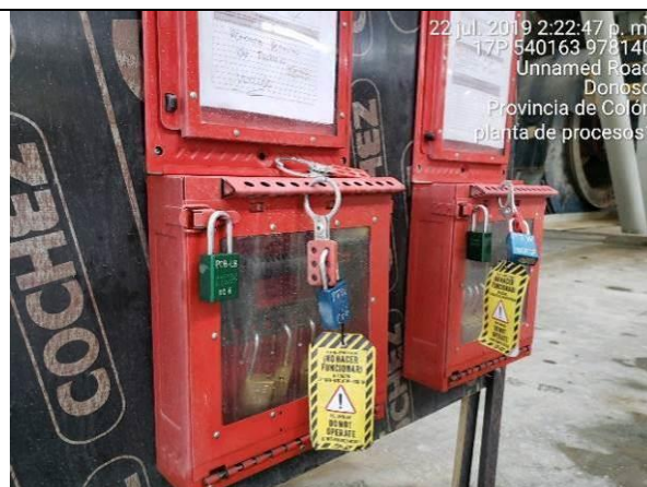
Imagen 355. Sistema LOTO, apagado seguro, en la Planta de Procesos, área de molinos (978140 N/ 540163 E)
