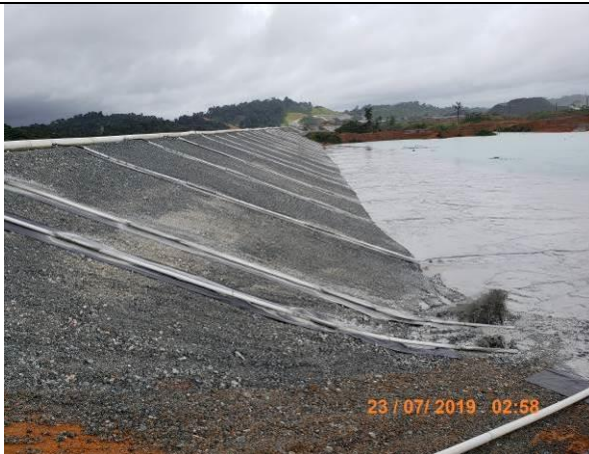
Imágenes 37 y 38. Detalle del enrocado de la Presa Norte de la IMR y tubería de alimentación de los relaves hacia la tina (983263 N/ 588440 E) y detalle de diseño de construcción de la presa con el uso del Sistema Aguas abajo + Center Line.
