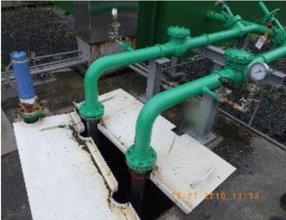
Imágenes 30 y 31. Sitio para retiro del sobrenadante oleoso de la descarga de agua al mar (996935 N/ 533884 E)
