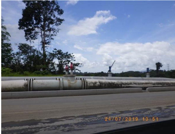
Imágenes 76 y 77. Tuberías de agua de proceso de un diámetro mayor, que van desde la Planta de Procesos hasta la IMR, en el Camino de tuberías o Pipeline road (980721 N/ 539491 E)
