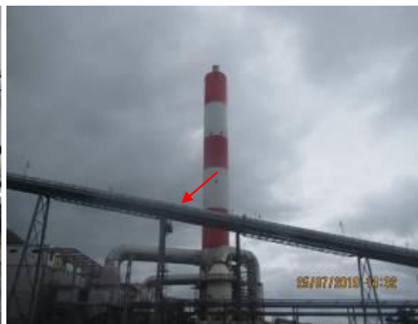
Imágenes 34 y 35. Vistas de la faja transportadora de carbón (996303 N/534034 E)
