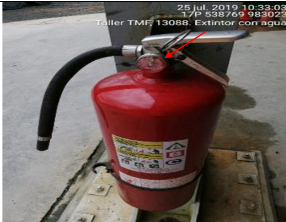
Imagen 169 a 171. Extintores comprometidos en el Taller de Mantenimiento de equipos pesados (978084 N/ 538758 E), Taller de Mantenimiento TMF (983023 N/538769 E) y Taller Mecánico de equipos livianos Punta Rincón (996014 N/ 533694 E)
