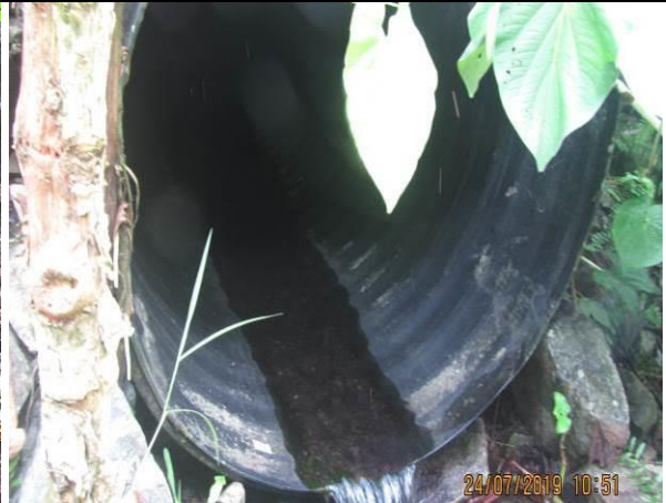
Imágenes 64 y 65. Cruce de corriente obstruido en la entrada del flujo en el Camino de Acceso Este (975980 N/ 542305 E)
