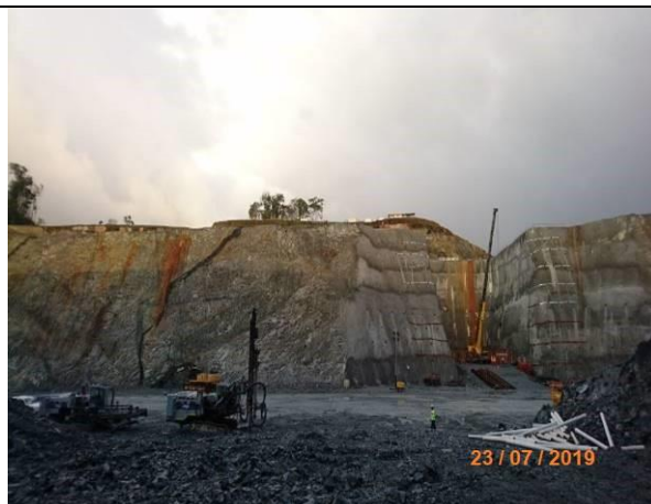
Imagen 370. Track drill para perforación y voladura; al fondo cortina de concreto para sellado de fracturas en paredes del talud, pernos de anclaje y colocación de malla electrosoldada para reforzamiento de las paredes del boxcut (977551 N/ 537692 E)
