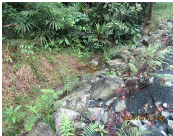
Imágenes 72 y 73. Cruce de corriente (flujo) sin alcantarilla en el Camino Morpho (994279 N/ 533414 E)
