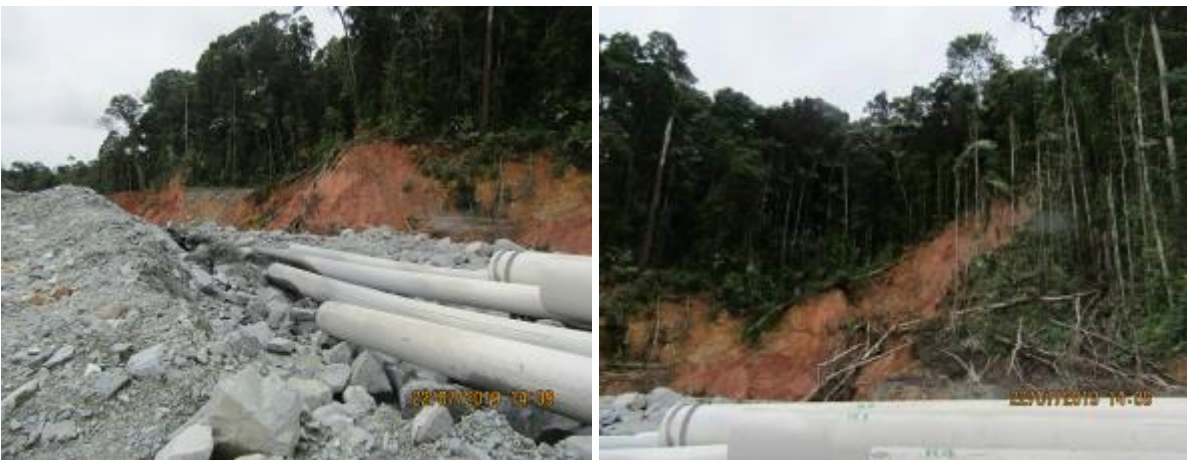
Imágenes 381 y 382. Ausencia de control erosión en sitio de descarga de agua de proceso (978556 N/ 537876 E)
