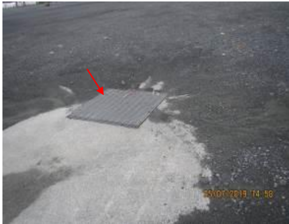
Imágenes 246 y 247. Trampa de aceites en el área de la Terminal 1 (997049 N/ 533396 E)
