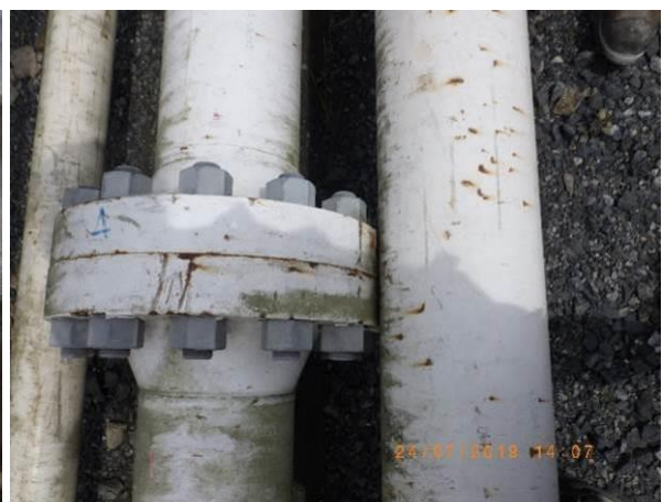
Imágenes 9 y 10. Bridas en contacto con las tuberías del Mineroducto (985470 N/ 537021 E)
