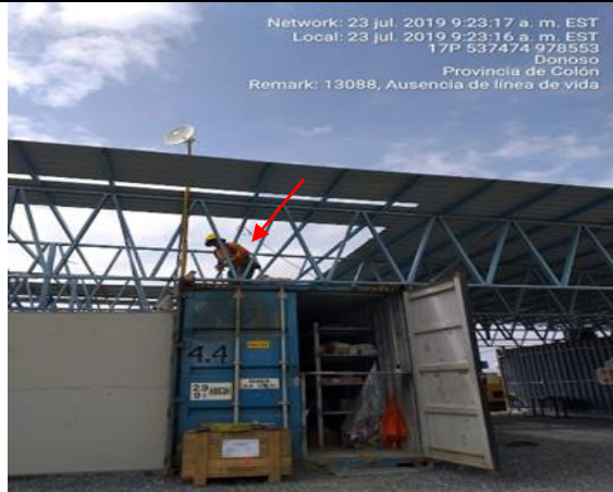
Imágenes 180 y 181. Colaborador realizando trabajos de altura con arnés sin anclaje a línea de vida, en el Área MSA (978311 N/ 538900 E)
