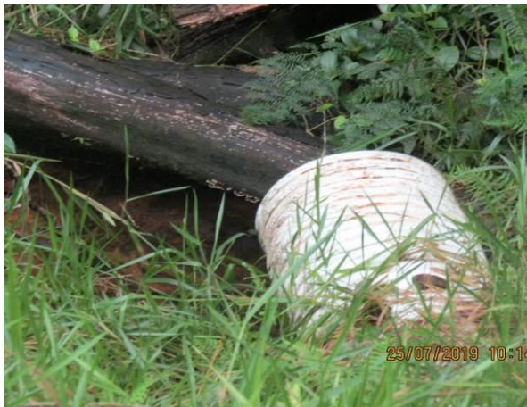
Imágenes 68 y 69. Alcantarilla que no se ubica al ras del suelo en el Camino Morpho (994300 N/ 533482 E)
