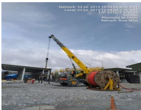
Imágenes 182 y 183. Correa de la eslinga de grúa sin inspección, en el Área MSA (978449 N/ 537164 E)
