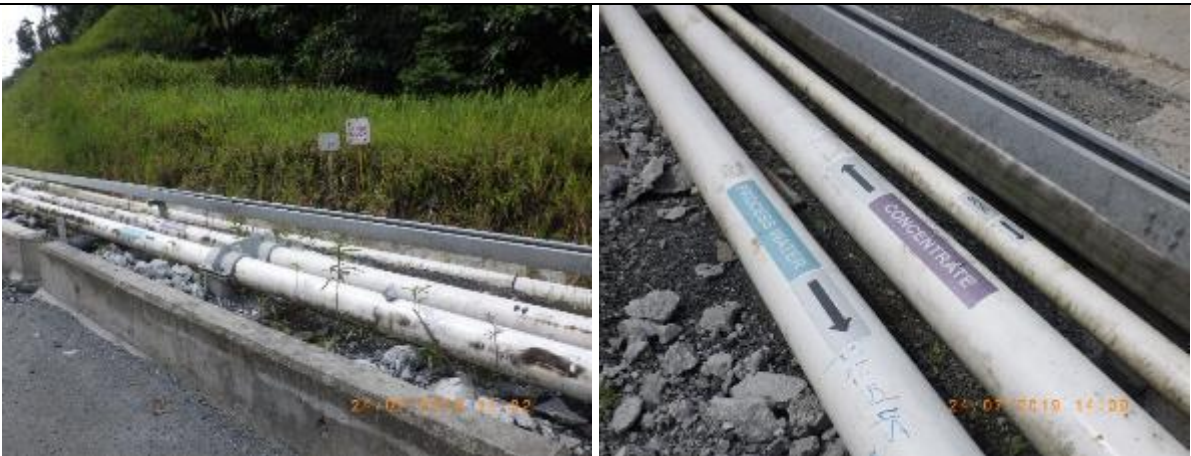
Imágenes 16 y 17. Mineroducto instalado en el Camino a la Costa (983012 N/ 538966 E) y tuberías del Mineroducto para agua de proceso, concentrado y diésel (985470 N/ 537021 E)
