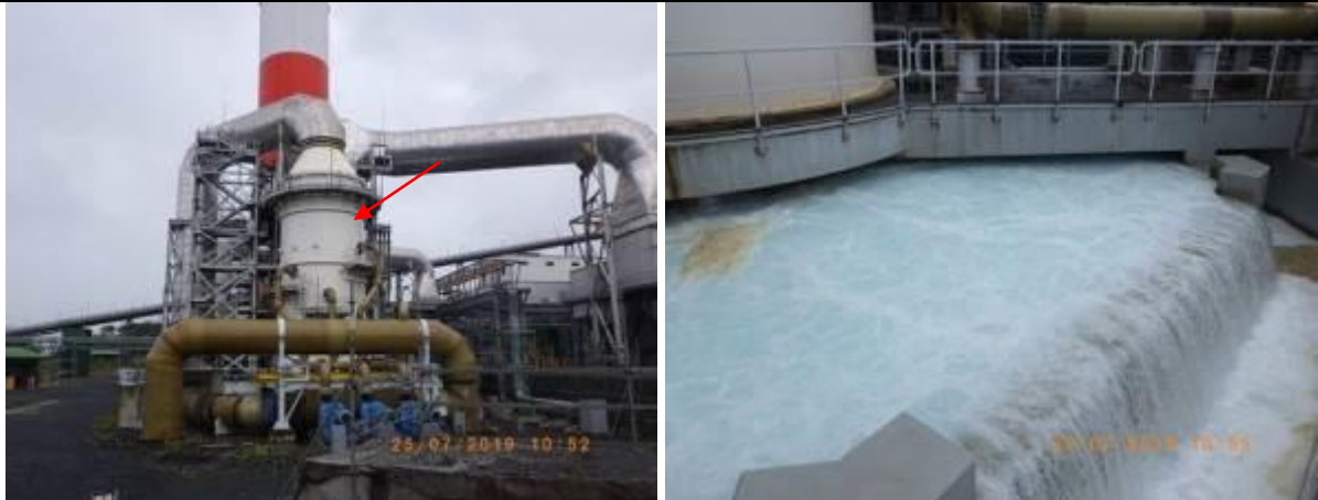
Imágenes 24 y 25. Vista de la unidad de desulfuración de gases de combustión (996883 N/ 533836 E)
