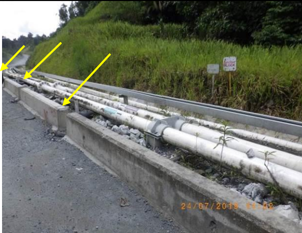
Imágenes 74 y 75. Tuberías del Mineroducto a lo largo del Camino a la Costa y protección no continua con espacios entre tramos que facilitan el paso de fauna (987162 N/ 535136 E)
