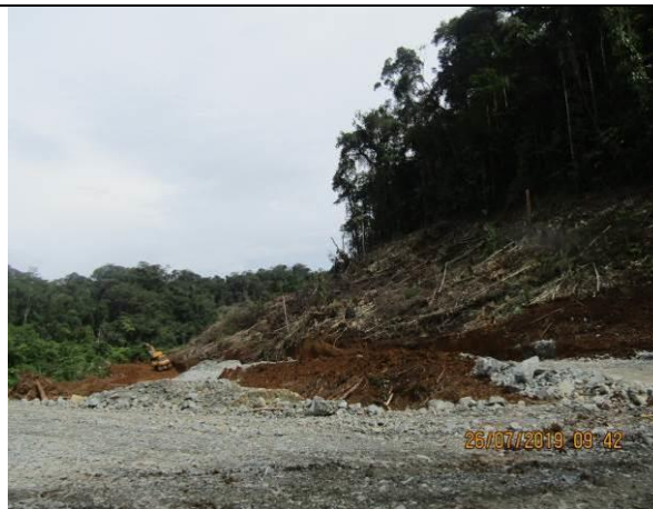
Imágenes 371 y 372. Relleno de un tramo del río Uvero (Del Medio), 976823 N/ 536320 E
