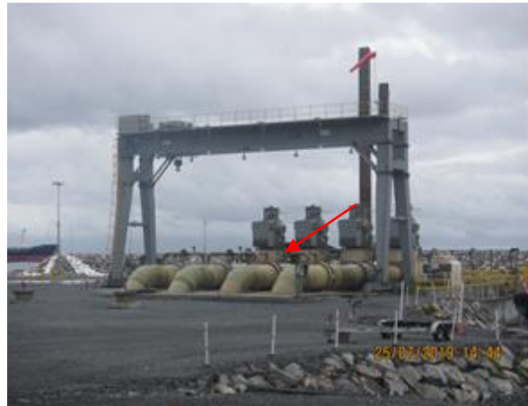
Imagen 26. Difusores de descarga al mar de la Planta de Generación Eléctrica (997132 N/ 533514 E)
