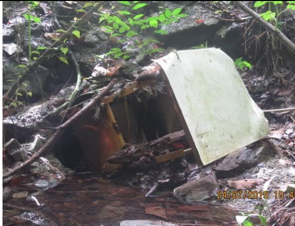
Imágenes 64 y 65. Cruce de corriente obstruido en la entrada del flujo en el Camino de Acceso Este (975980 N/ 542305 E)
