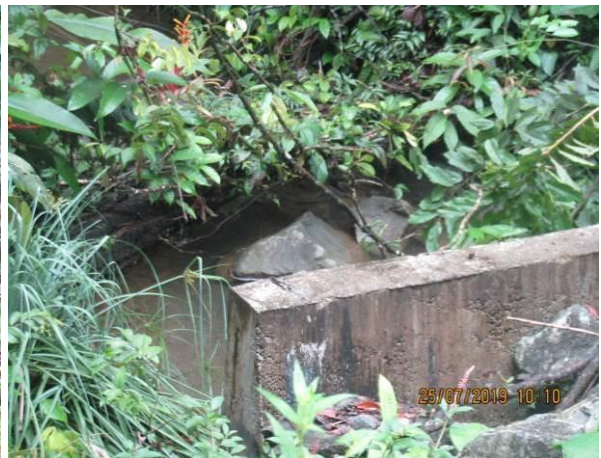
Imágenes 66 y 67. Alcantarilla a ras de suelo que permite el paso de peces aguas arriba y abajo en el Camino Morpho (994377 N/ 533705 E)
