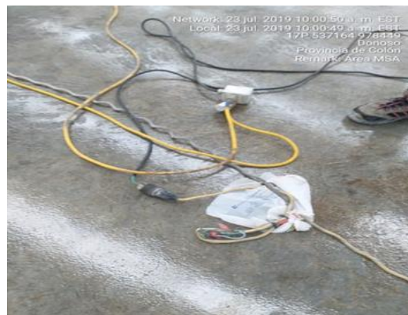
Imagen 190. Extensión eléctrica con cables descubiertos en el Área MSA (978449 N/ 537164 E)
