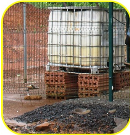
Fotografía 9 Tanque plástico de almacenamiento de combustible para la planta eléctrica de respaldo, sobre bloques de arcilla
