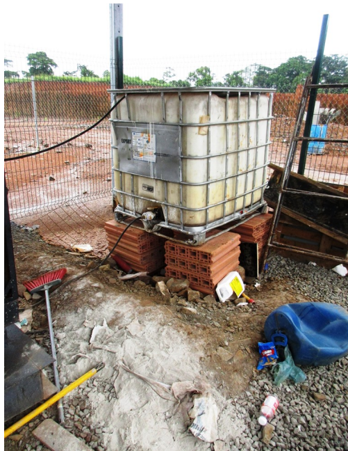
Fotografía 22 Tanque de gasolina para el generador eléctrico de respaldo
