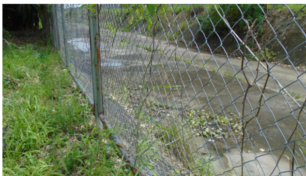
Canal Pluvial Seco.
