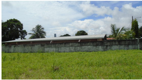
Vivienda en sitio colindante.
