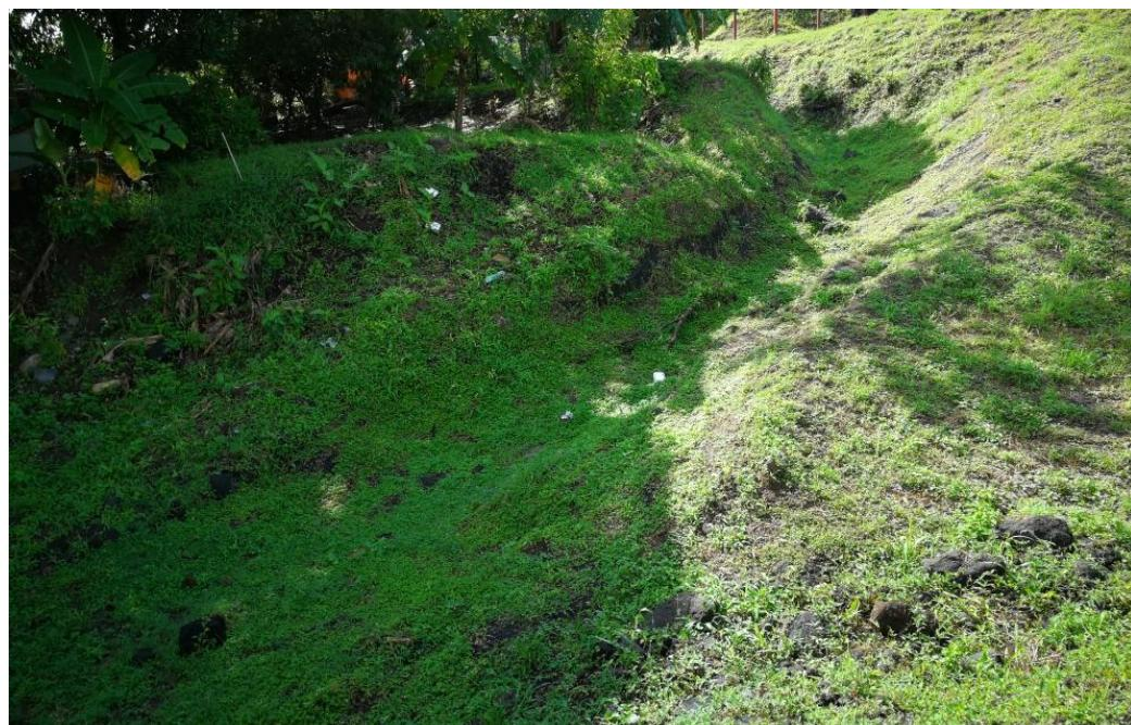
Como medida de control de erosión, también se observa que los canales pluviales construidos aún conservan el recubrimiento geotextil y se ha vegetado espontáneamente. Esta medida se construyó para evitar desprendimiento de material suelo y de retención de sedimentos.
