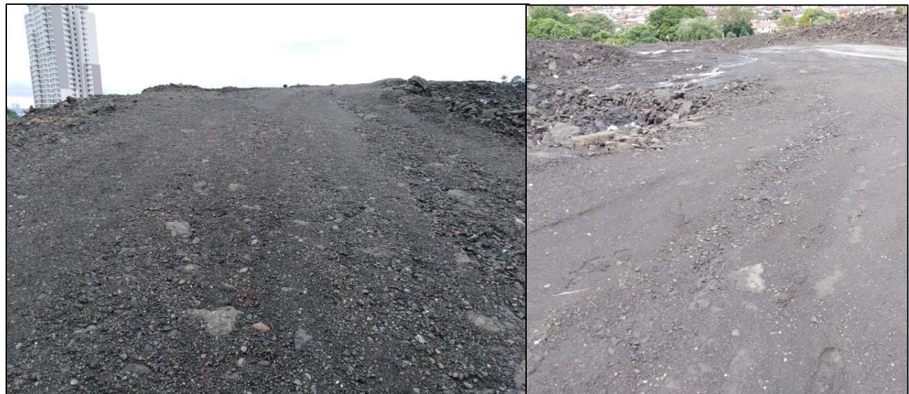
Se habilitan taludes y otras acciones de protección hacia colindantes. Conforme se rebaja la roca se construyen bermas con área de distanciamiento con colindantes para que amortigüen en caso de caída de roca suelta. Esto como medida de protección hacia colindantes
