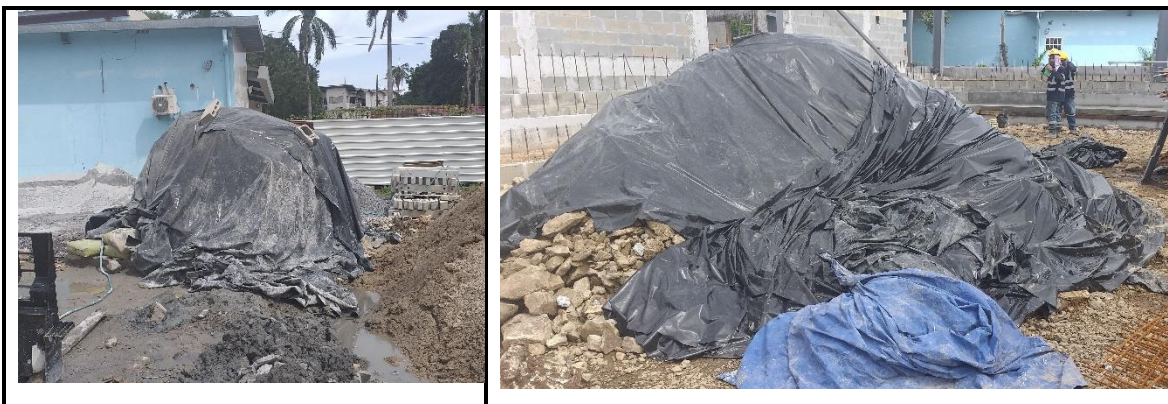
Foto No. 5 Colocación de plástico en los acopios de materiales particulados
