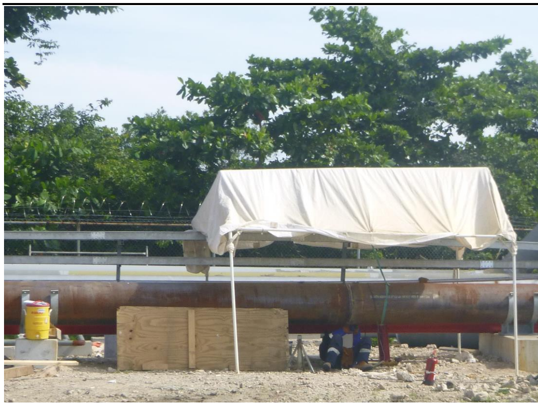
Figura 12 Realización de trabajos de soldadura bajo sombra. Presencia de contenedor para agua y extintor cerca de la estación de trabajo
