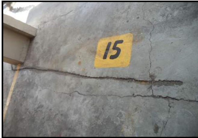
Piso y rampa de estacionamiento presenta grietas / fisuras
