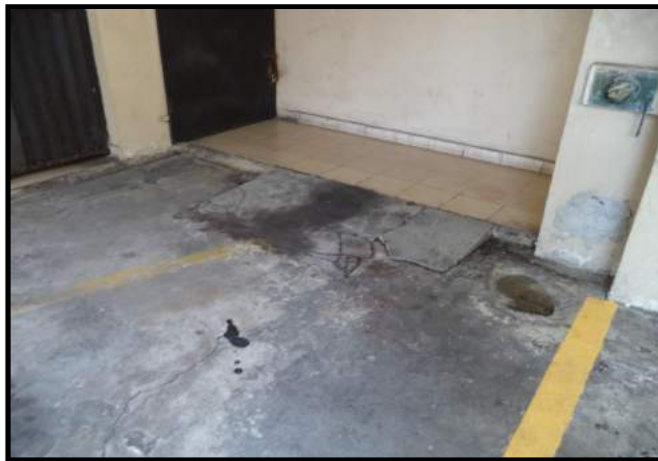
Piso y rampa de estacionamiento presenta grietas / fisuras
