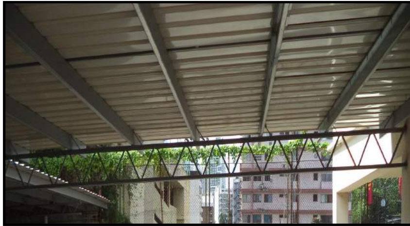
Vista del voladizo del Edificio Tolía el mismo presenta pintura descascarillada
