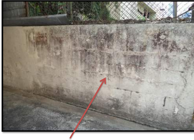
Se visualiza muro sin repello – humedad y mal estado de la pintura
