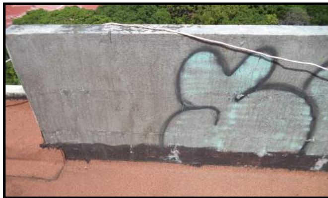
Vista de la pared del muro perimetral de la azotea: se observa pinturas color oscura y grafitis.
