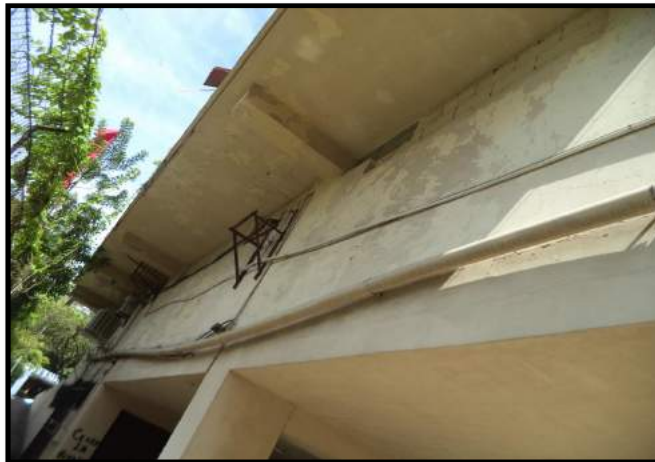
Vista del voladizo del Edificio Tolía el mismo presenta pintura descascarillada
