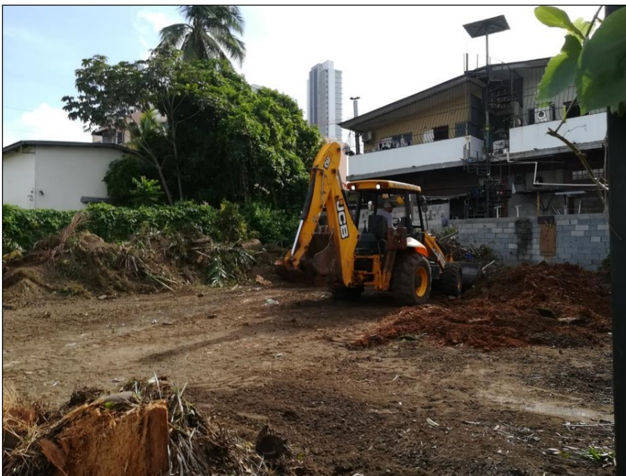
Foto #8. Retroexcavadora realizando la remoción de la capa vegetal, así como de ramas y troncos de los árboles y palmas encontrados en el lote.
