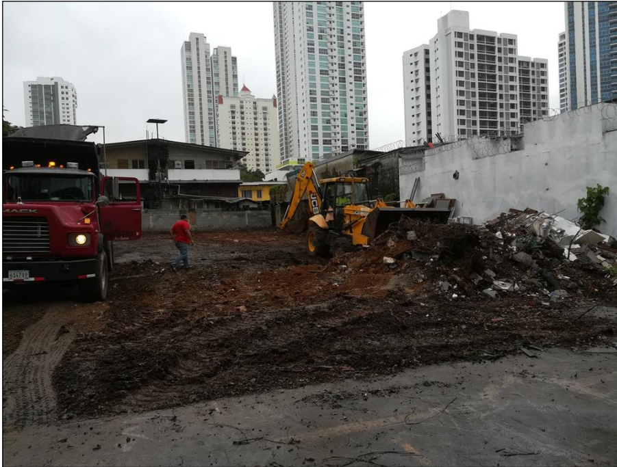
Foto #15. Retroexcavadora cargando el camión con los escombros.
