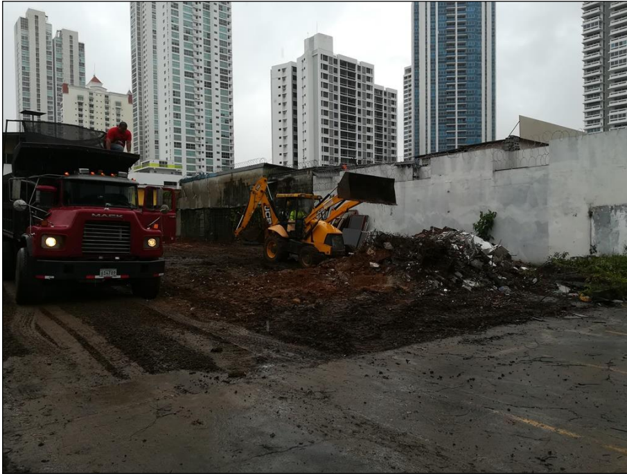
Foto #13. Retroexcavadora removiendo los escombros. Se ha mantenido la losa frontal de los estacionamientos
