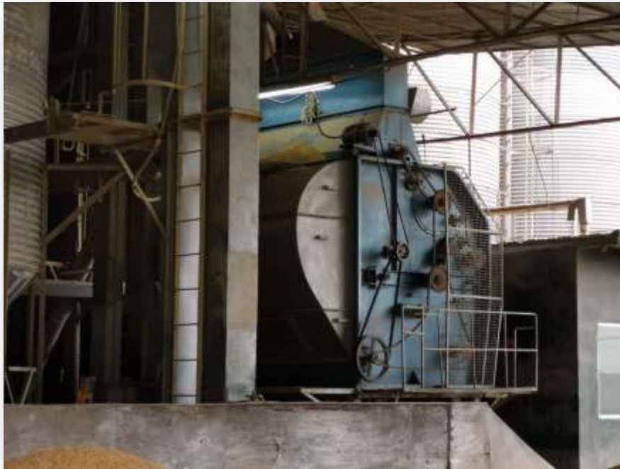
Imagen 8. Vista general del área de pre-limpieza.
