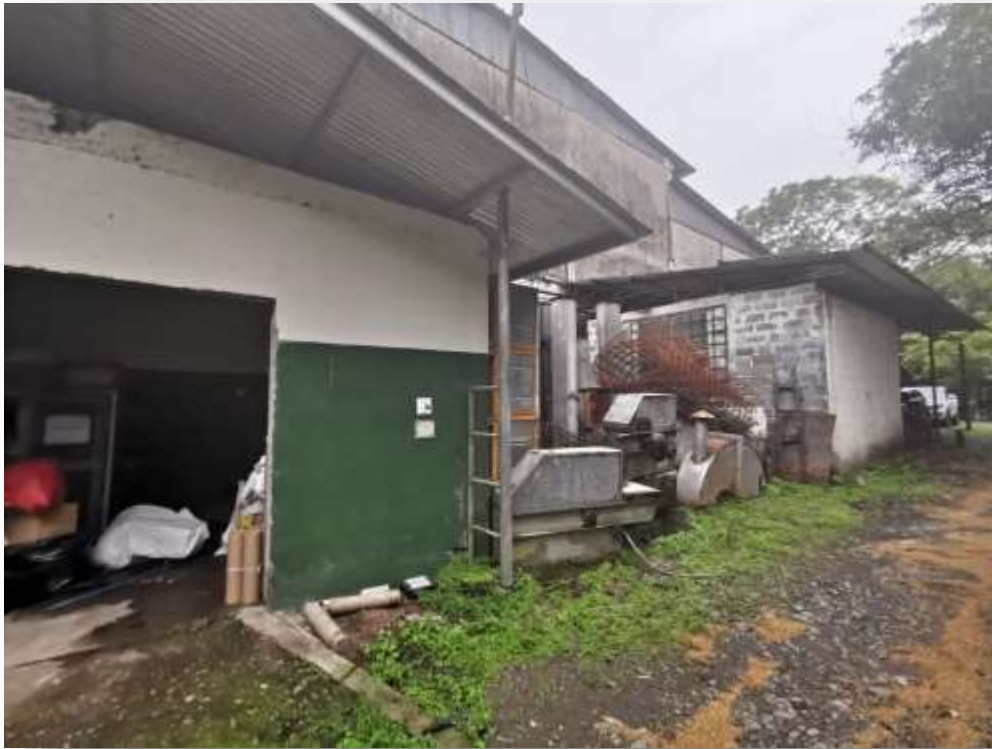
Imagen 22. Vista del depósito externo.
