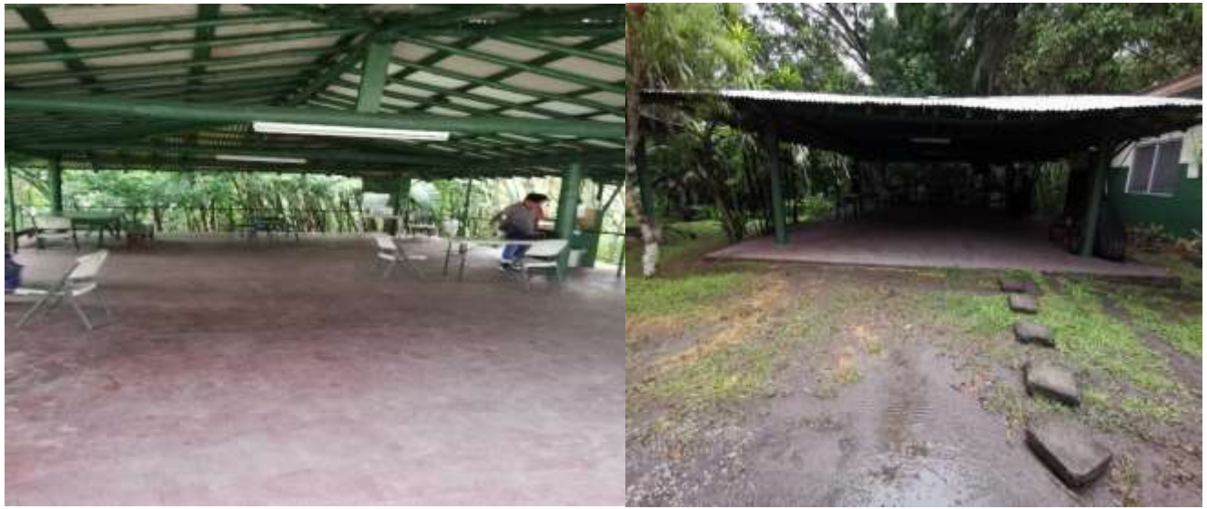
Imagen 23. Vista del área de comedor y cocina.
