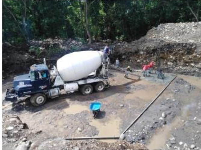
VACIADO DEL CONCRETO DE REPOSICION PARA LA PLANTA DE TRATAMIENTO
