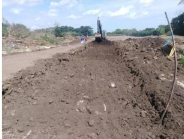
CORTE DE LA CALLE PRINCIPAL A NIVEL DE TERRACERIA
