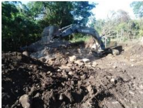
EXCAVACION DE FUNDACION DE LA PLANTA DE TRATAMIENTO
