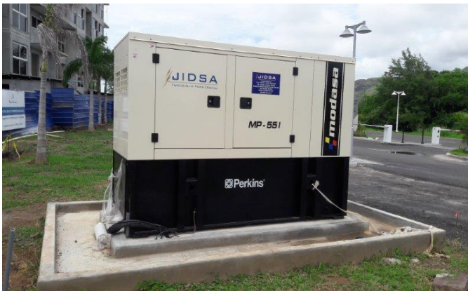
Generador eléctrico con tina de contención de derrames
