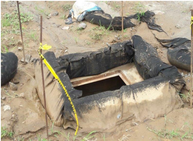
Cordón de contención de sedimentos en tragantes pluviales
