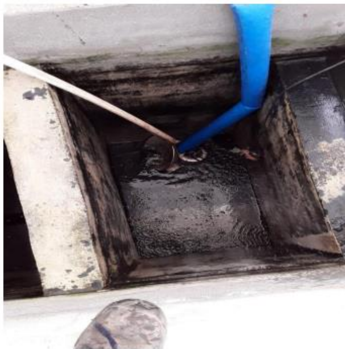
Limpieza de canal de descarga
