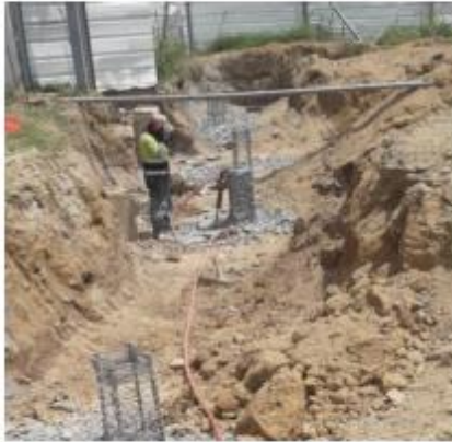
Inicio con descabezado de Pilotes
