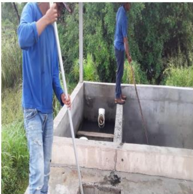
Limpieza de canal de salida
