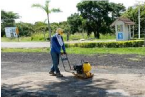
Compactación de capa base para estacionamiento Aires del mar
