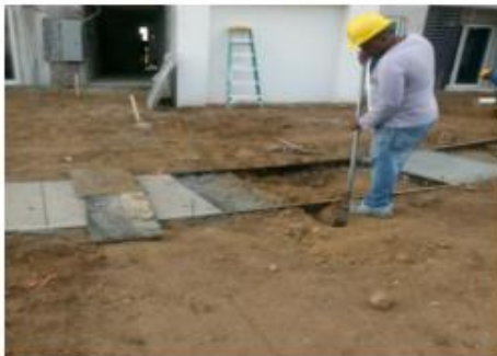
Fabricación de aceras de áreas Común.
