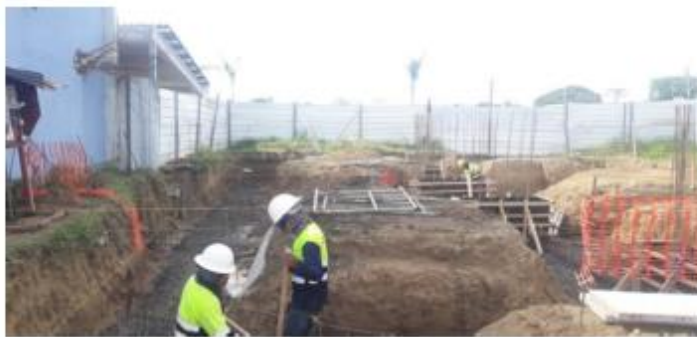
Inicio con descabezado de Pilotes
