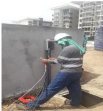
Alambrado Eléctrico de Cuarto de Bomba de Piscina
