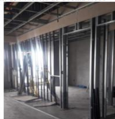
Estructura para Paredes Livianas N 600
