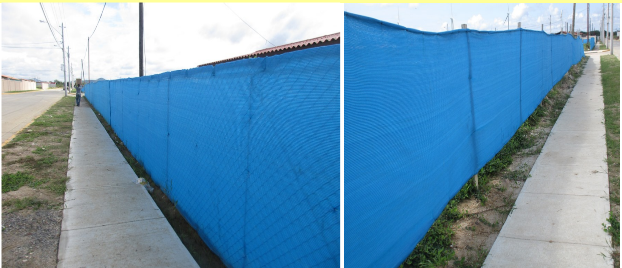
Fotografía 41 Barreras físicas que separan las áreas en construcción de aquellas con acceso público
