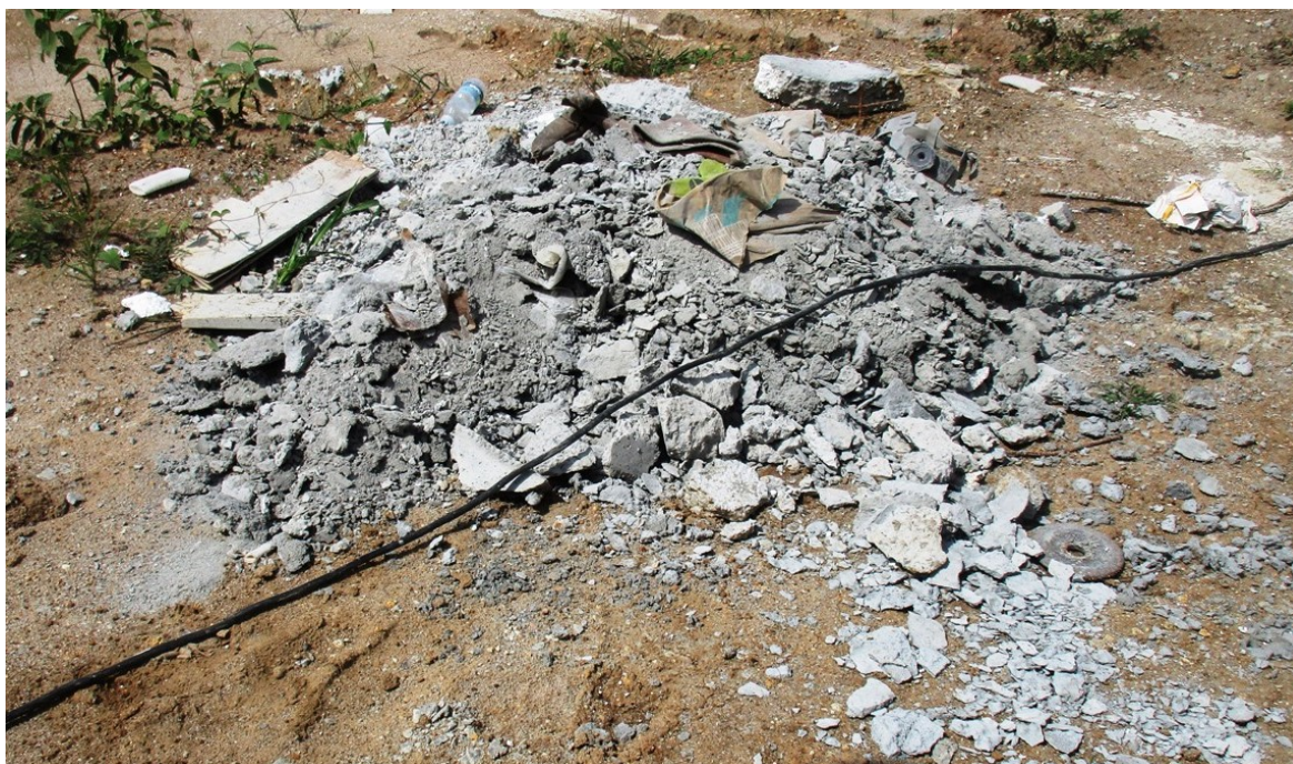
Fotografía 14 Restos edáficos y caliche limpio acopiados para luego ser empleados como relleno
