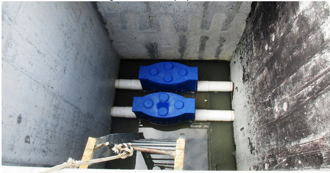
Fotografía 16 Caja de clorinación de la PTAR
