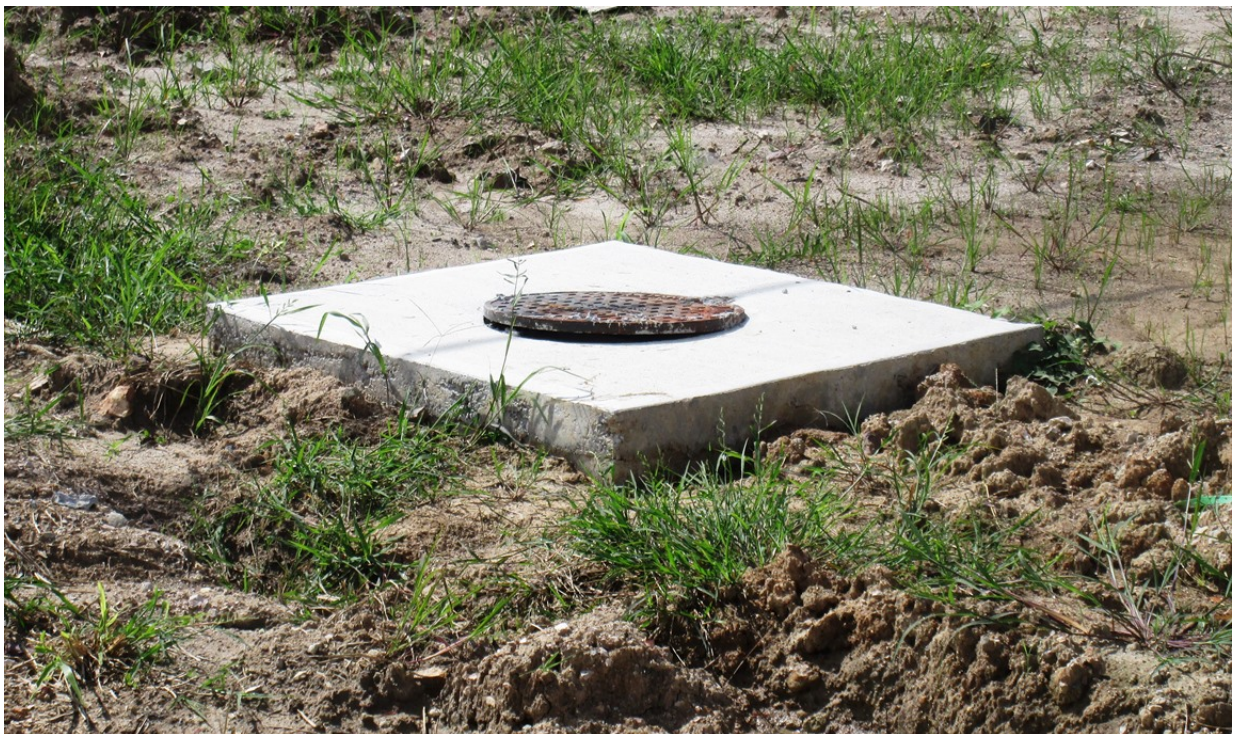
Fotografía 45 Cámara de Inspección (C.I.) del sistema sanitario
