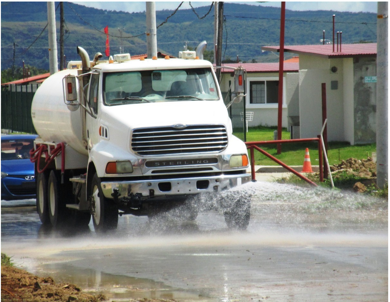
Fotografía 9 Aspersión de agua sobre las calles con camión cisterna, como medida de contención de polvos
