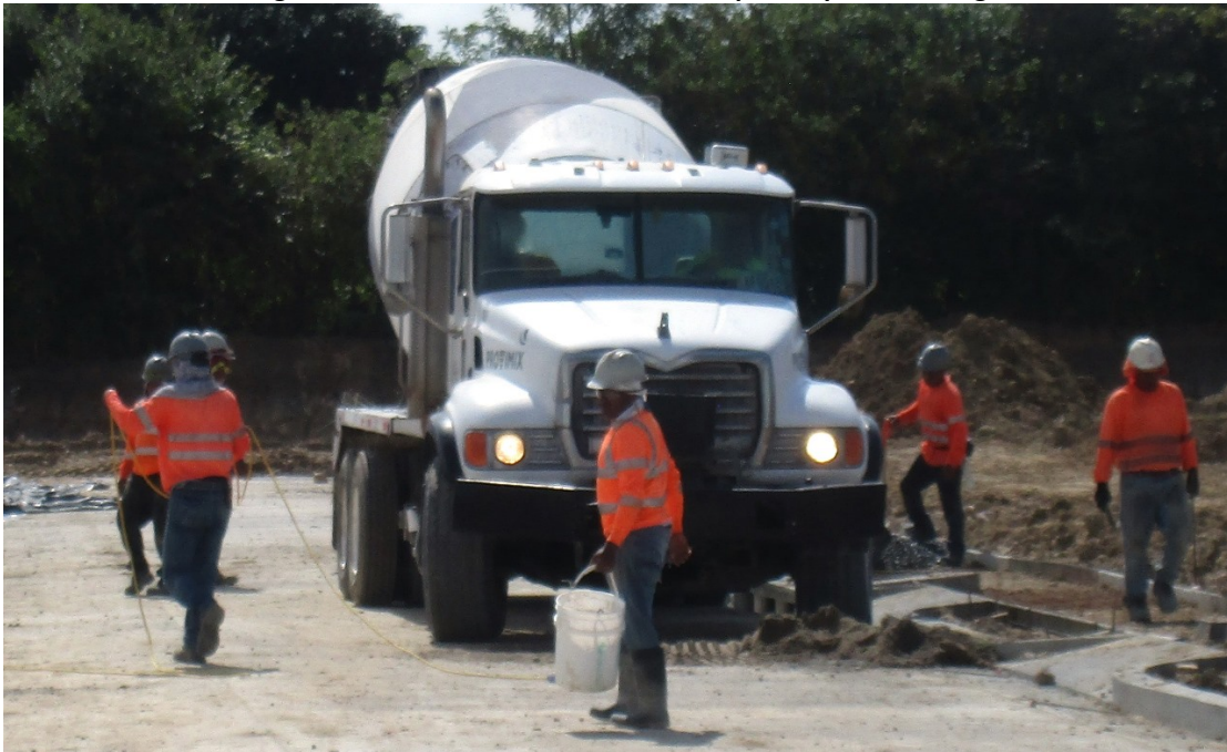
Fotografía 31 Camión para vertido de concreto empleado en el vaciado de las aceras
