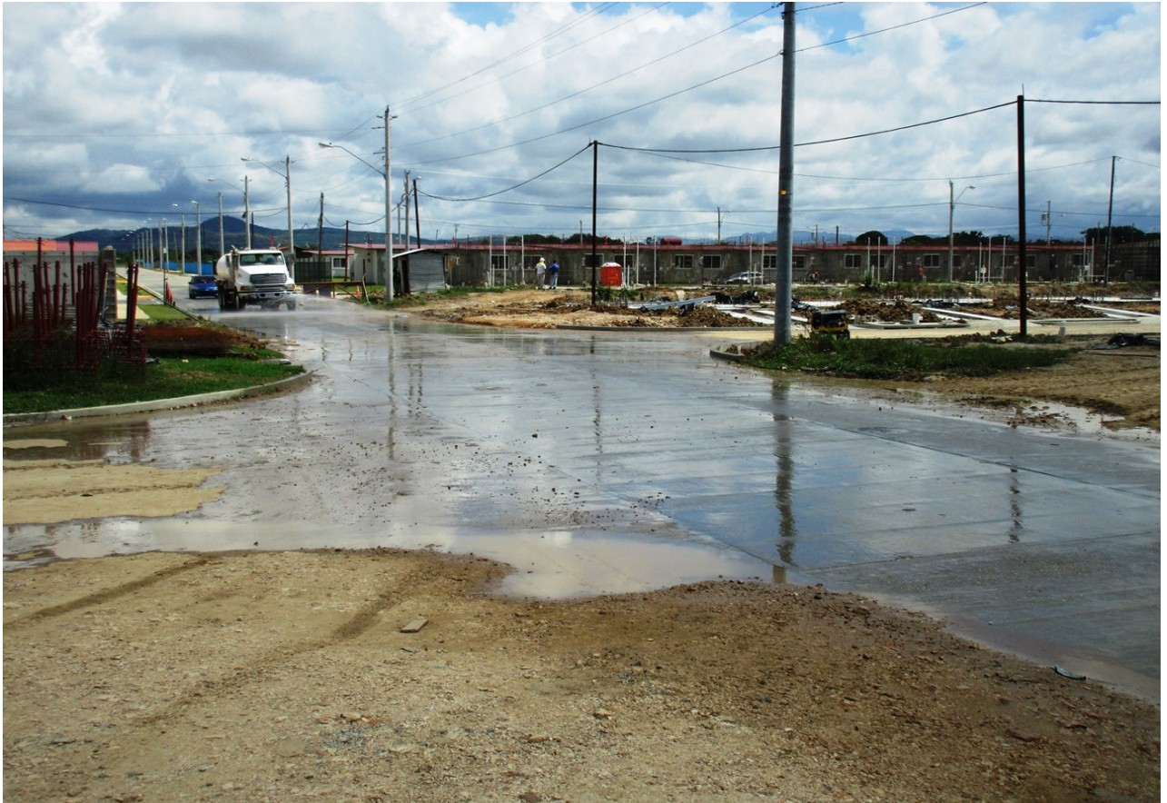
Fotografía 44 Aspersión de agua sobre la calle como medida de contención del polvo
