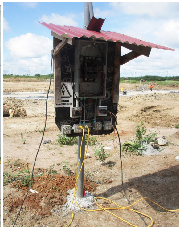
Fotografía 27 Temporal eléctrico con letrero sobre riesgo eléctrico
