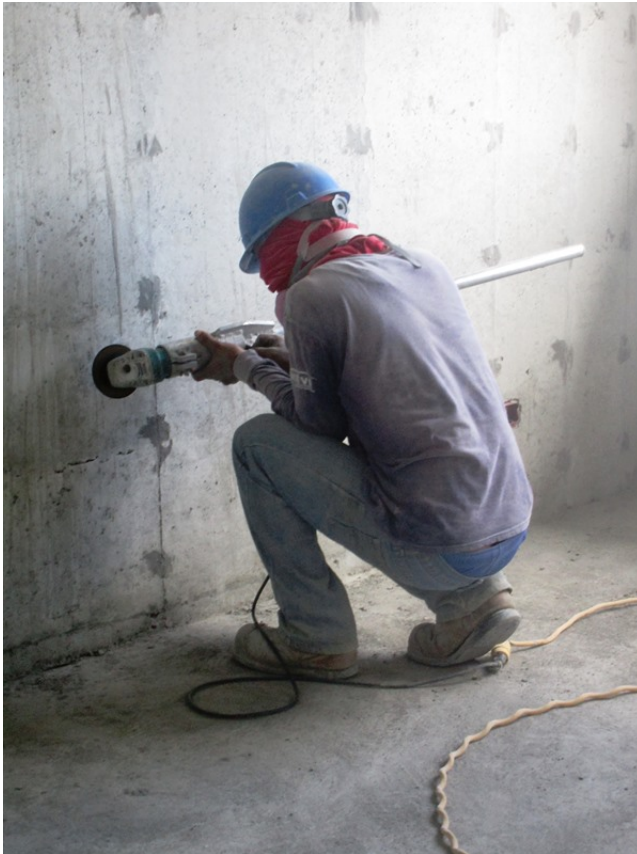
Fotografía 23 Trabajador con su EPP completo, desbastando una pared
