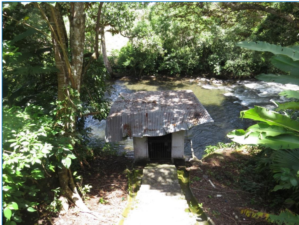
Fotografía N°16. Cauce del río Divalá. Fuente: Equipo consultor, octubre 2019.
