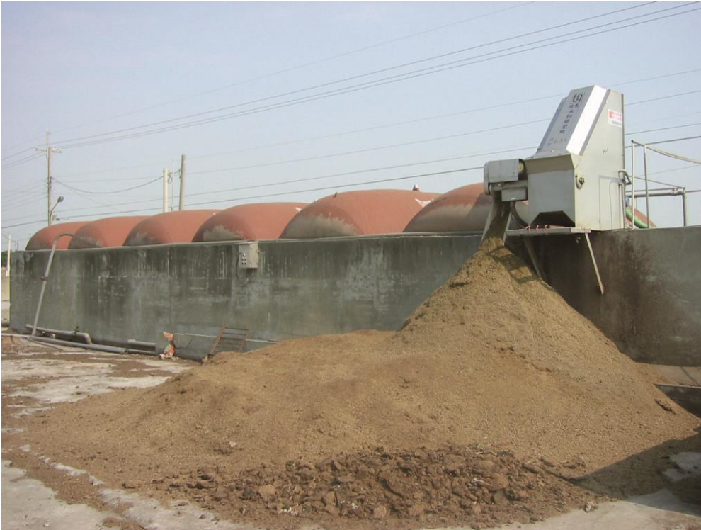
Figura 2. Sistema compuesto de Separador de Solidos, y biodigestores para la fermentación anaeróbica de agua residuales
