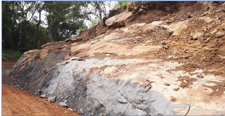
Fotografía 1. Vista de las rocas existente
