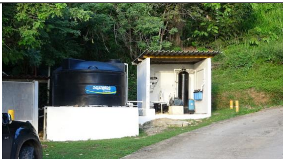
Foto 38) Pozo, sistema de filtrado y tanque primario de almacenamiento
