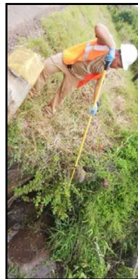
Puente Quebrada El Roble 1+927
