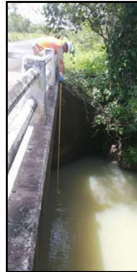
Cajón sobre quebrada de Barro
