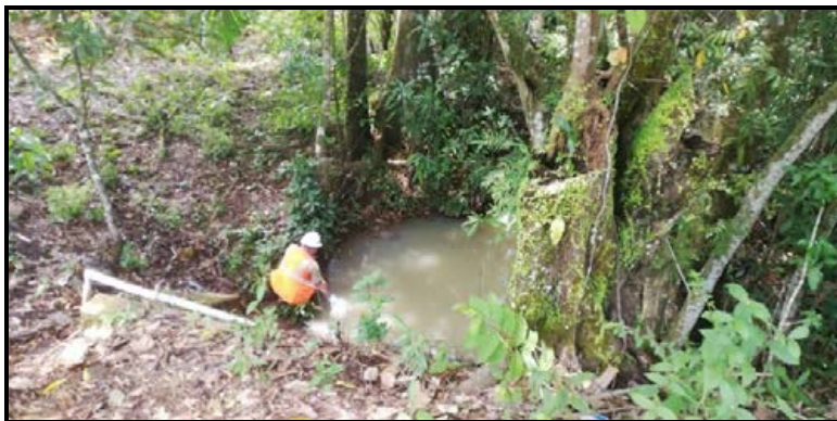
Cajón sobre quebrada Botijuela 25k+700
