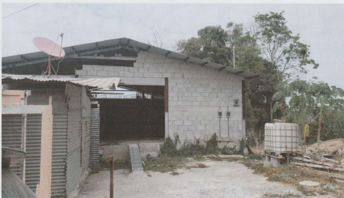
Foto N° 4: Vista panorámica del área frontal del proyecto, planta alta. Fuente: Julio Cruz /octubre /2019.
