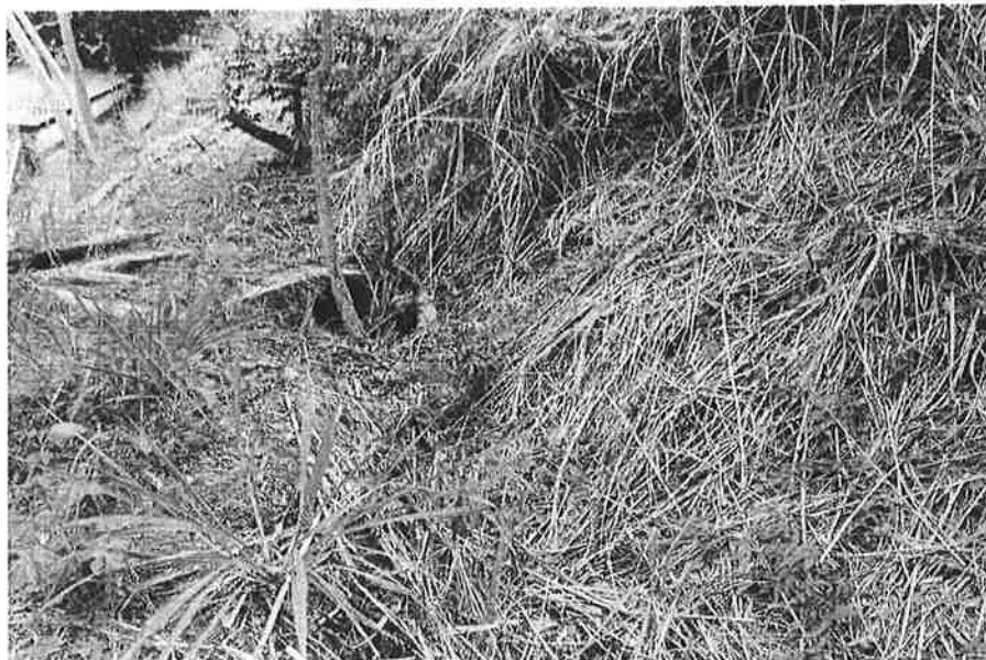
Sistema de drenaje observado en el sector, obstruido por la vegetación y posiblemente con poca capacidad
