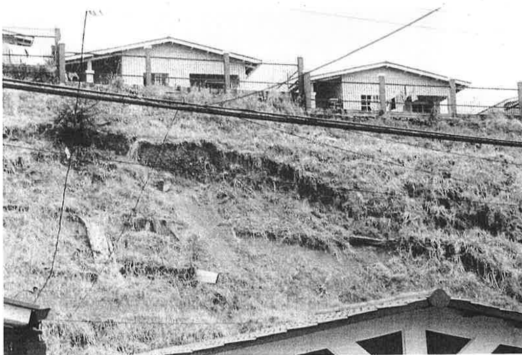
Corona de deslizamiento en toba bien meteorizada, en la parte posterior de la vivienda P516.
