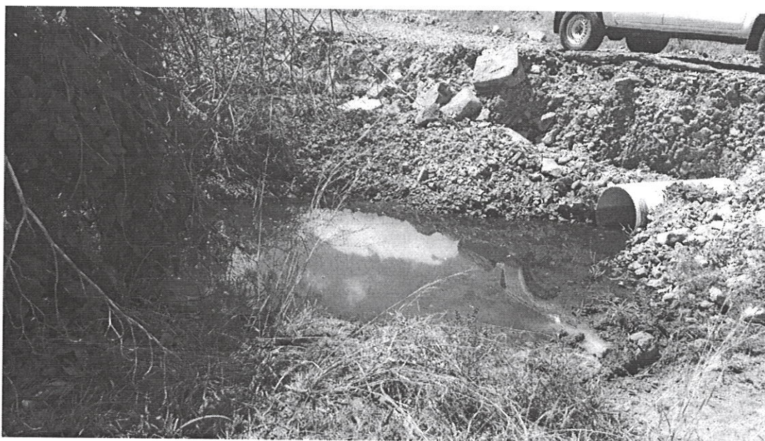
Fig. No. 5: Vista de la obra en cauce construida en el afluente de la Quebrada Los Remedios (sin nombre), se observa que no se han aplicado controles de erosión y sedimentación.
