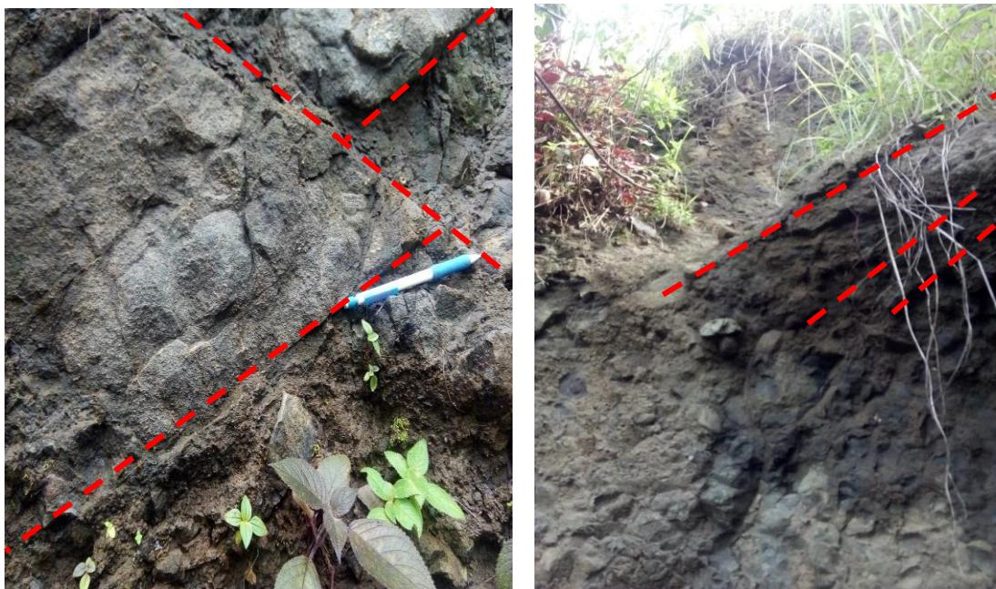
Figura 6. (a) Talud mostrando un aglomerado volcánico compacto diaclasado en dos direcciones preferenciales mostradas en trazos rojos. (b) Aglomerado volcánico diaclasado en la parte superior del talud.
