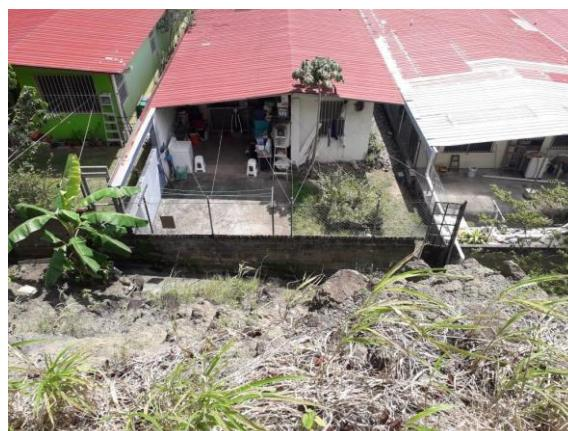
**Figura 13. Talud de aglomerado andesítico con matriz tobácea con presencia de bloques rodados.**
