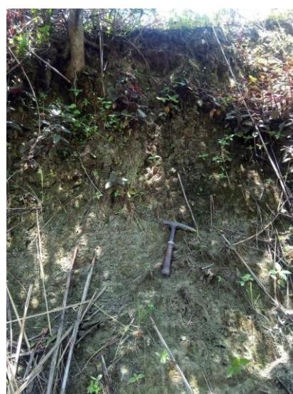
**Figura 3. Afloramiento de toba meteorizada en talud.**
