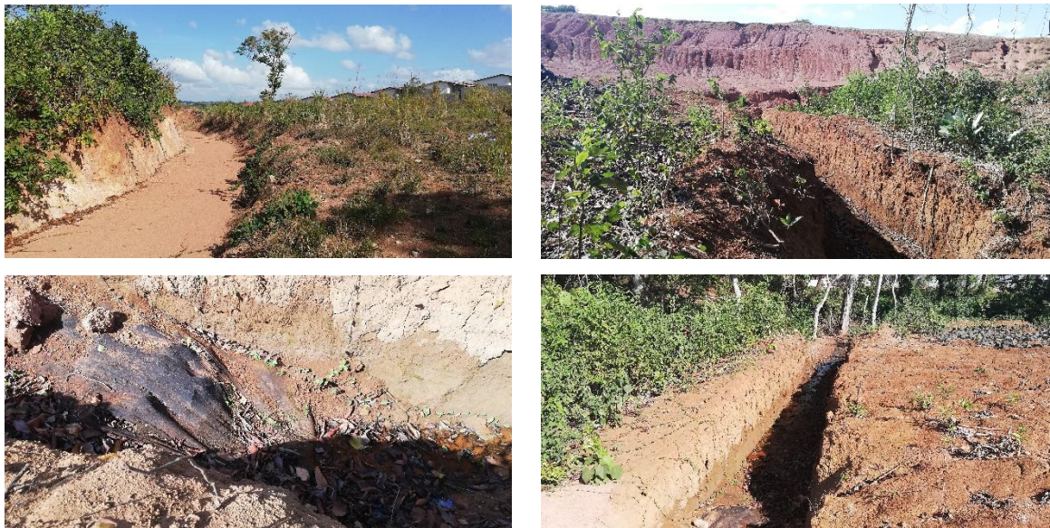
Fuente: Equipo consultor del EsIA Figura 6.12. Drenajes artificiales y drenaje francés del vecino.
