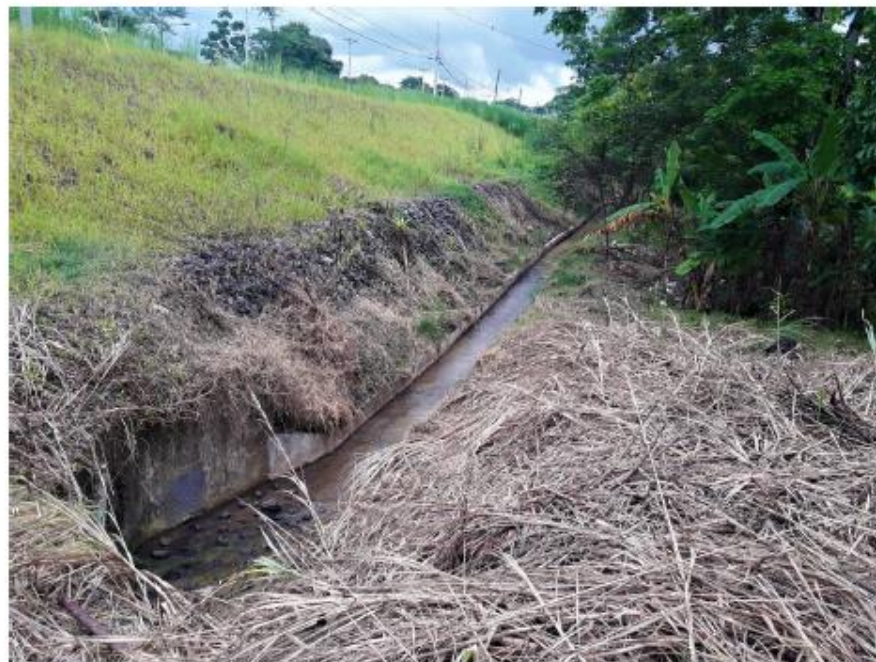
Foto 4. Vista de Canal concreto rectangular b=1.25 m h=0.35 m en parte frontal del terreno
