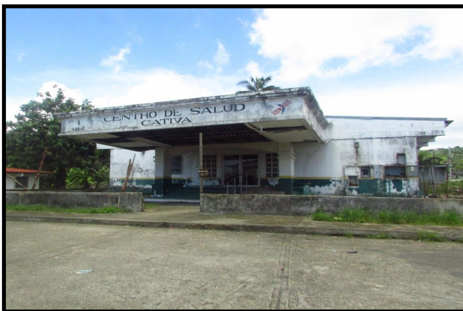
Figura #24. Instalación del Centro de Salud
