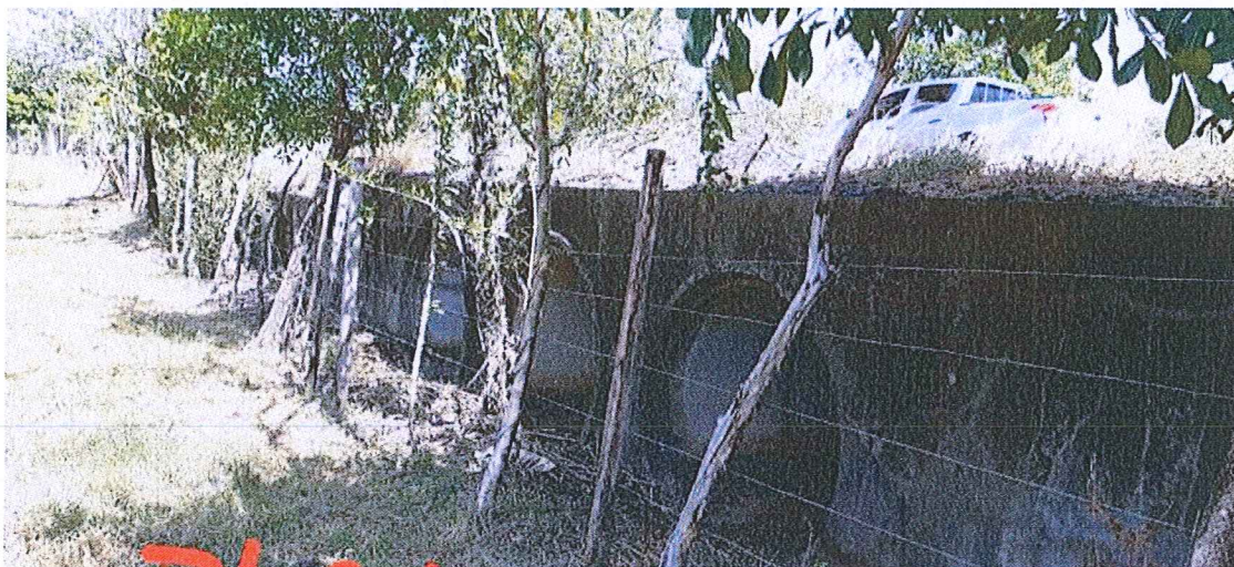
Figura n° 20. Obra de Drenaje con 5 Tubos D100 cm. Est. 95k680
