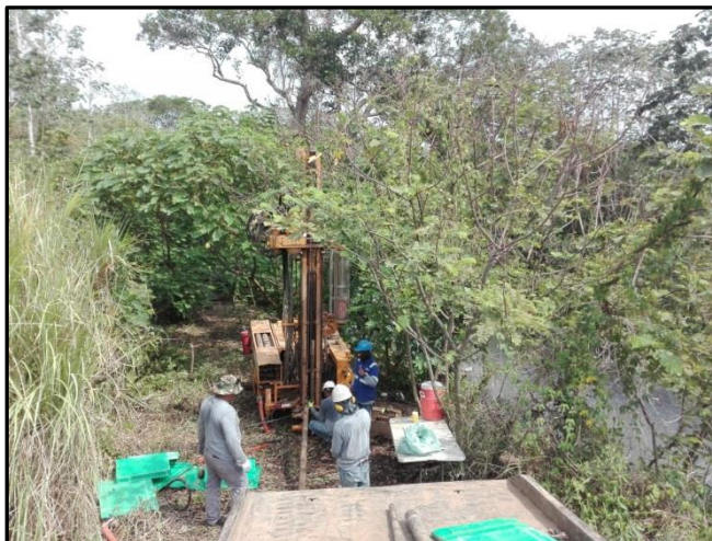
Figura 5. Equipo de perforación utilizado en la ejecución de los sondeos
