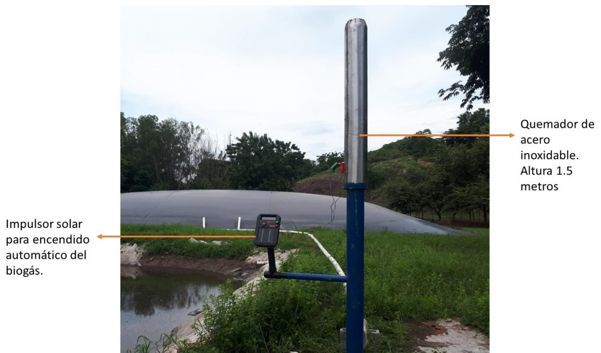
Foto 1. Quemador de biogás. Fuente: Ing. Juan Raúl Carrasco, Proyecto Porcino - Los Santos, Panamá.
