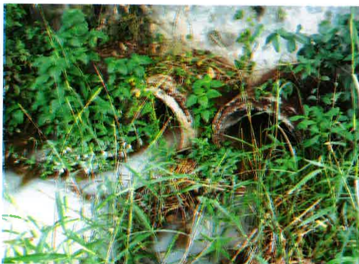
Fotografía 1 Tuberías de hormigón por donde circulan aguas de drenaje pluvial en el punto de descarga
