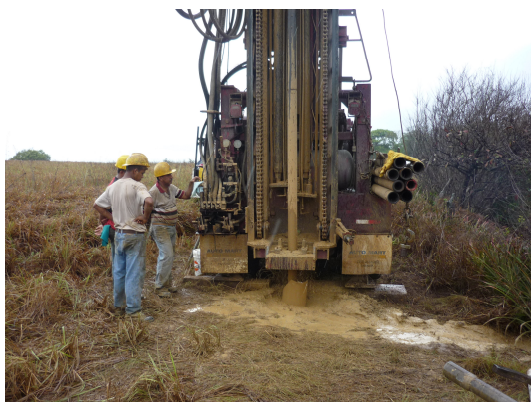
Secuencia de fotos durante las perforaciones, para análisis de cantidad y calidad de agua subterránea.
