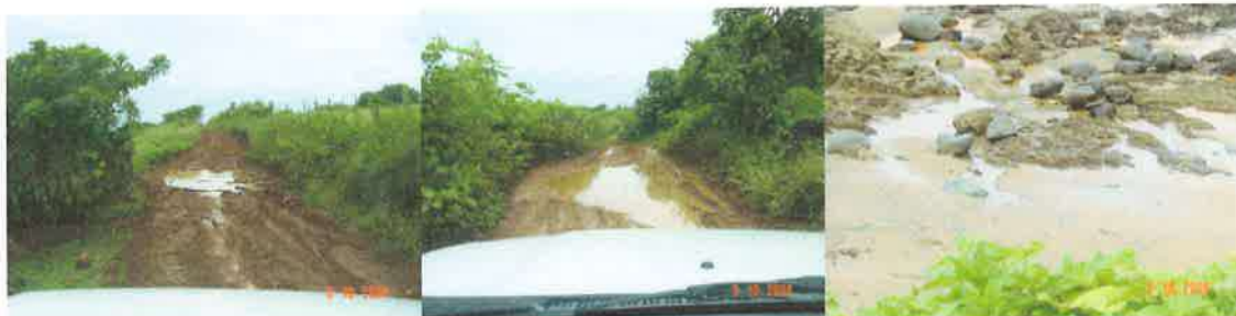
A la izquierda y centro, estado actual del camino de acceso público al proyecto. A la derecha se observa el efecto de la sedimentación en la zona marino costero o playa rocosa, por el mal estado y falta de control a la erosión en el camino de acceso público.
