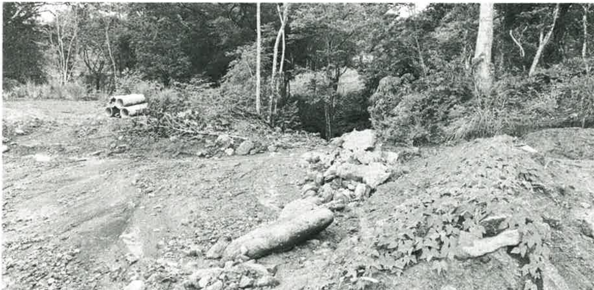
La Figura 5. La imagen muestra la acumulación del material dentro de la servidumbre de la quebrada y proceso de erosión del terreno sobre la misma.
