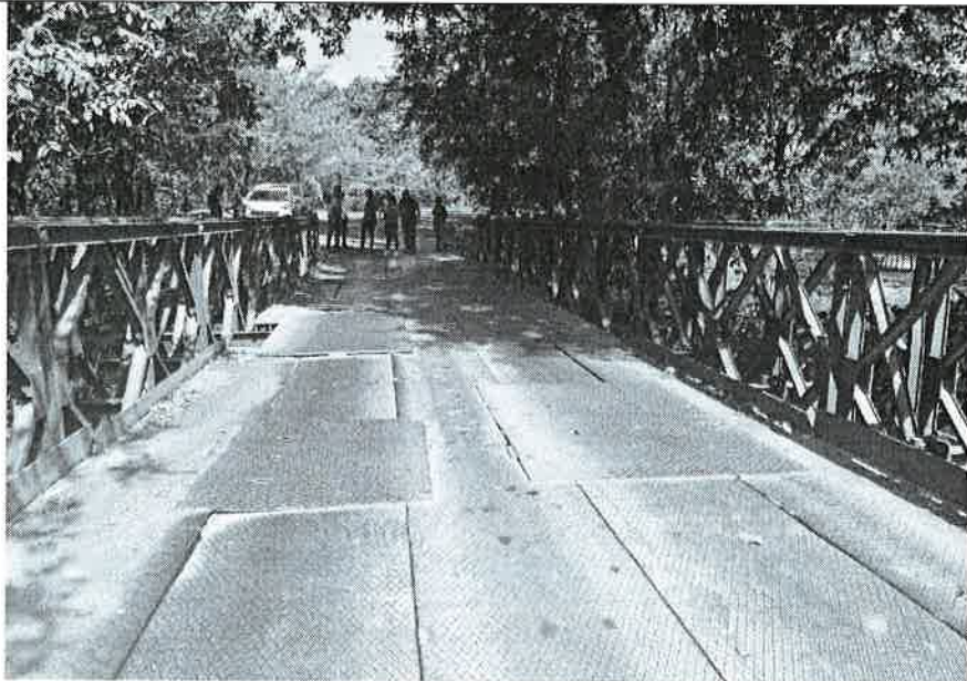
Puente tipo Bailey que será eliminada para la construcción de uno nuevo, ubicado en la comunidad del Palmilla.
