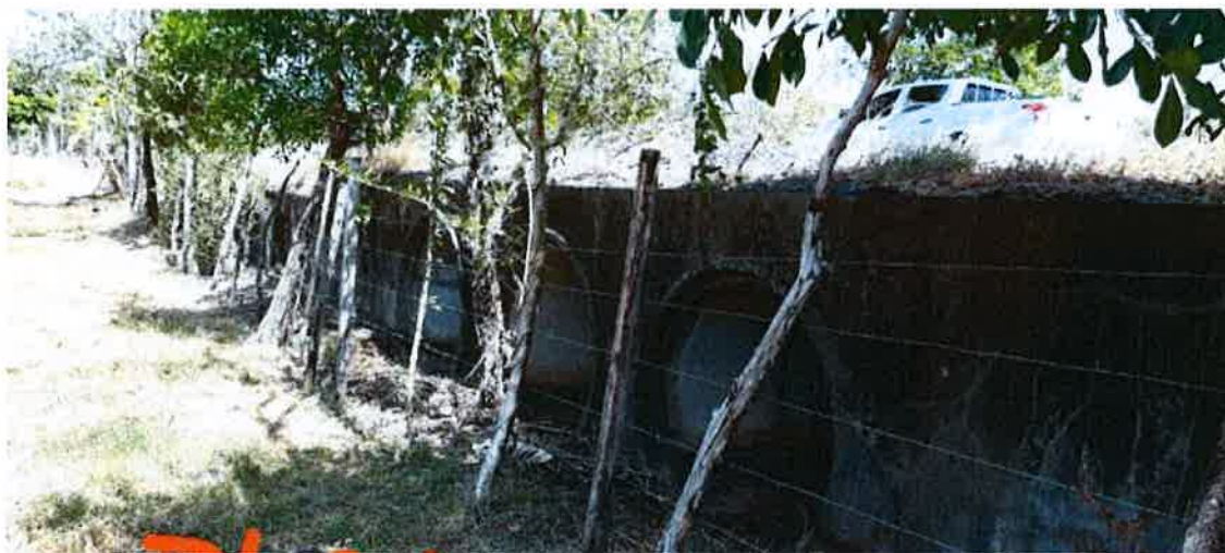
Figura nº 20. Obra de Drenaje con 5 Tubos D100 cm. Est. 95k680
