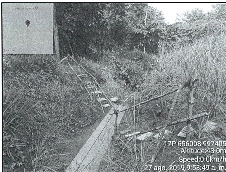
(Fig. 1) Se visualizó este canal realizado durante la construcción de la vía La Foresta, el cual desplaza las aguas pluviales de estas área que cuentan con cerros.
