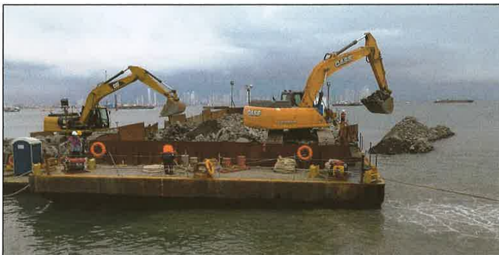
Ilustración 8. Vertido de roca con barcazas
